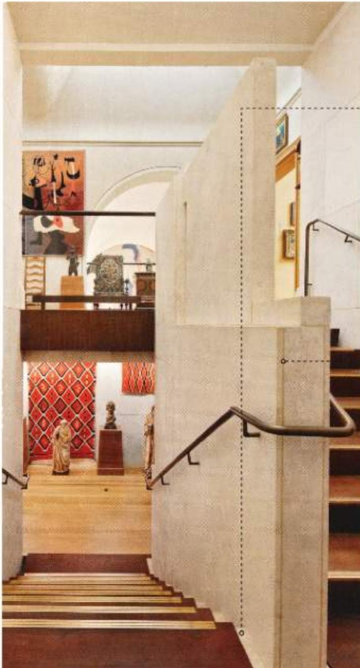
A SEPARAÇÃO DOS MATERIAIS EM DISCRETOS AFASTAMENTOS É SUTILMENTE REVELADA EM PEQUENOS ELEMENTOS EXIBIDOS NOS ESPAÇOS INTERIORES DA FUNDAÇÃO. OS DEGRAUS DE MADEIRA SÃO MANTIDOS SEPARADOS NA PAREDE, RESSALTANDO O FATO DE SEREM MATERIAIS DIFERENTES E INDEPENDENTES UNS DOS OUTROS.
