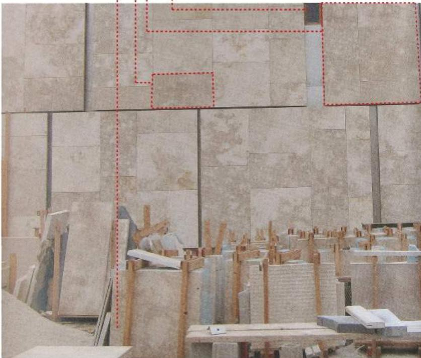
Fig 86 – Detalhe da separação dos painéis. Desenho gentilmente cedido pelo escritório do TWBT.
