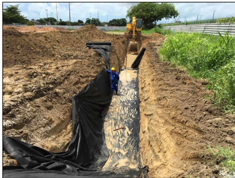
Figura 24 – Posicionamento do Geotêxtil na área de superfície do dispositivo
