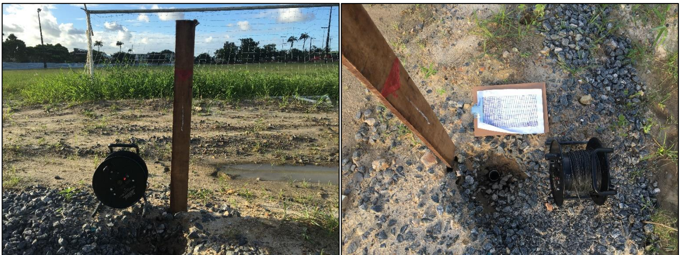
Figura 21 – Monitoramento piezométrico da trincheira de infiltração
