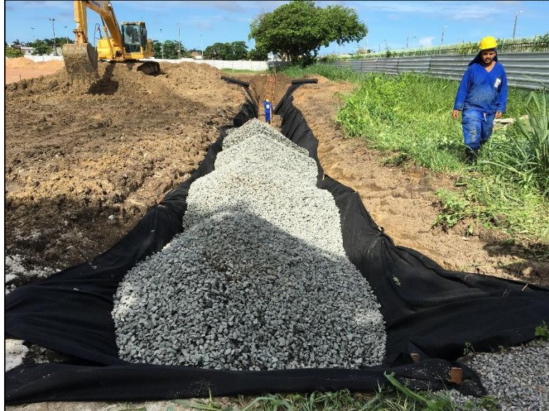
Figura 25 – Preenchimento da trincheira com material granular
