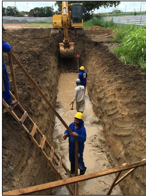
Figura 23 – Escavação do terreno e verificação da cota de fundo da trincheira via equipamento topográfico
