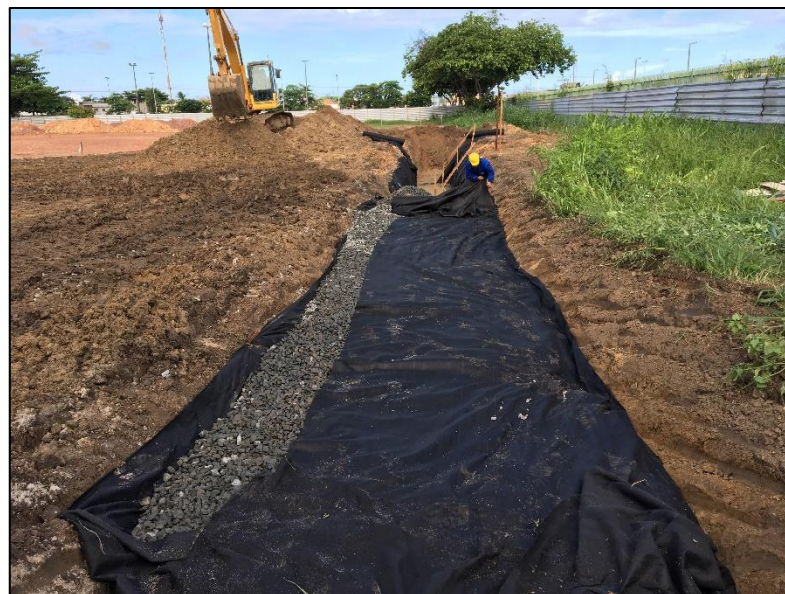
Figura 26 – Execução de geotêxtil superior e reaterro da trincheira
