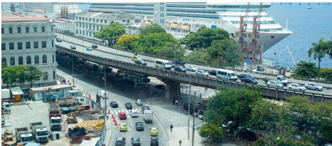
Figura 5 – Elevado da Perimetral em 2013.
