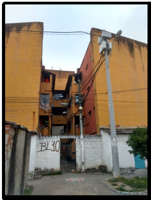
Figura 12 - Muro limitando o acesso ao bloco 10 do Conjunto.
