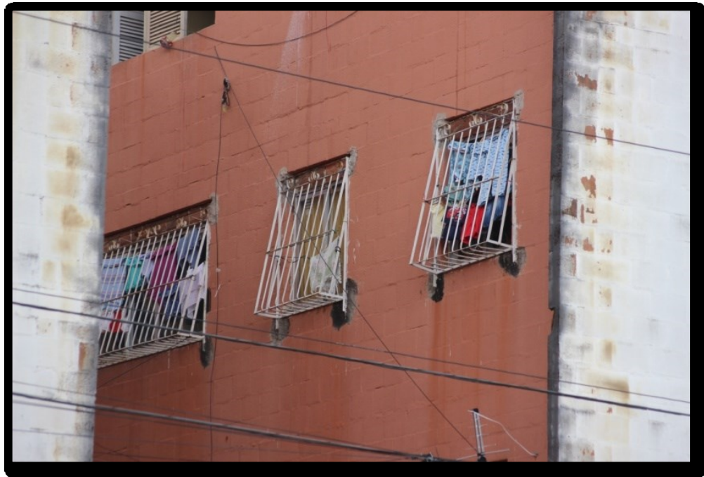
Figura 11 - Instalação de grades nas janelas dos apartamentos
