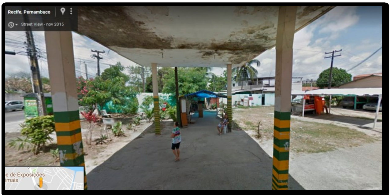
Figura 17 - Entrada do Conjunto em novembro de 2015, após o último período de demolições da prefeitura.
