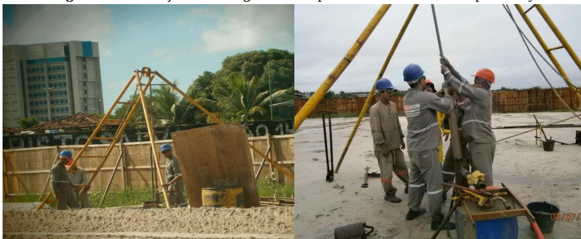
Figura 58 - Execução de sondagem a trado para retirada de amostra tipo Shelby
