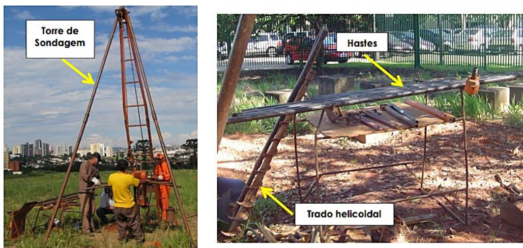
(a) Torre de sondagem completa
