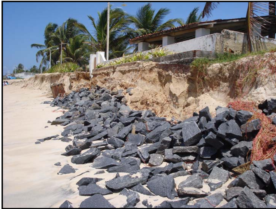
Figura 6: Transporte longitudinal, caso de erosão, praia de Enseada dos Corais, litoral sul de Pernambuco.
