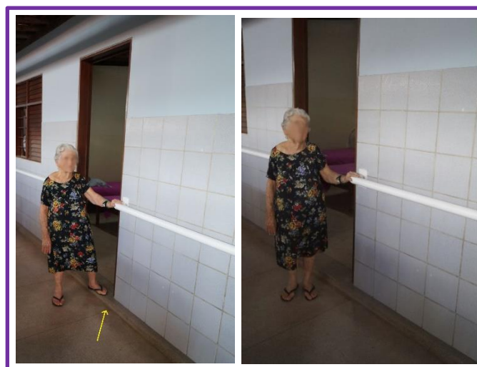
Figura 15. Descer o desnível em direção ao banheiro.
