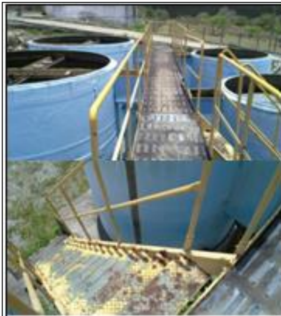
Figura 27 - Acesso à parte superior do sistema de filtragem.
