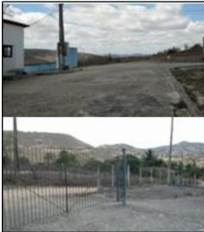
Figura 29 - local isolado ETA – Cumaru.
