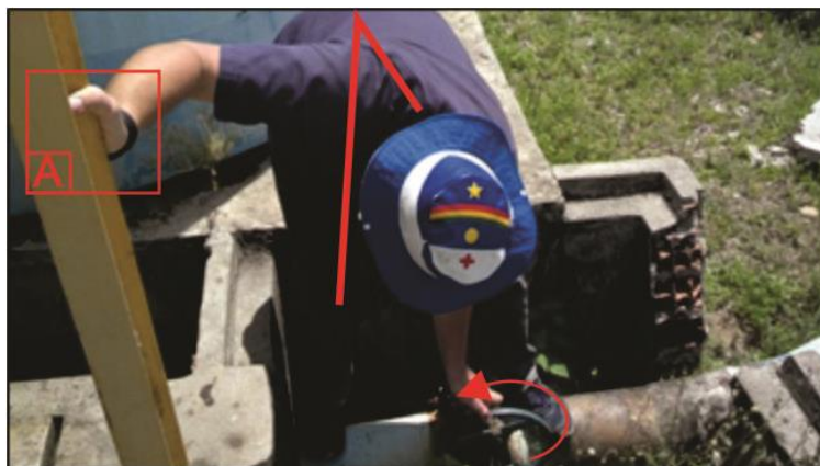
Figura 22 - Operador equilibrando-se em cima do cano “A” para fechar válvula de água bruta do filtro 1.
