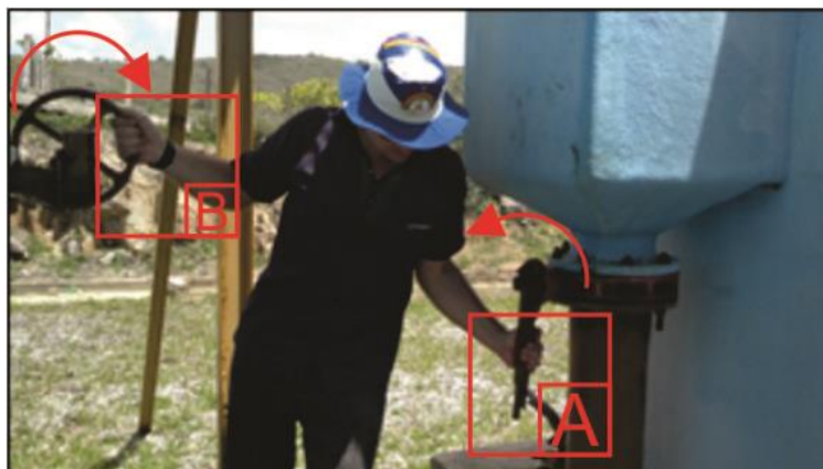
Figura 32 - Operador cansado se apoia em uma válvula “B” enquanto movimenta outra “A”.
