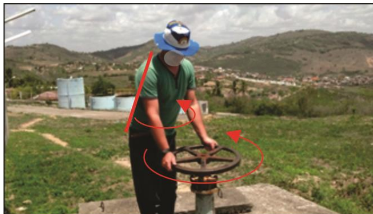
Figura 25 - Operador regulando vazão de entrada de água bruta.
