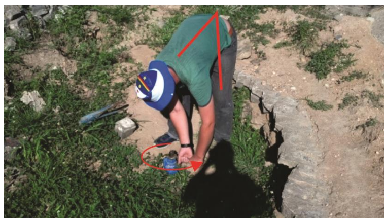
Figura 23- Operador abrindo válvula de água tratada para o bairro (Jenipapeiro).
