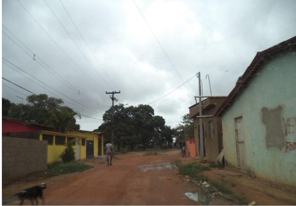
Figura 12 - Rua sem pavimentação e saneamento no município de Araçoiaba
