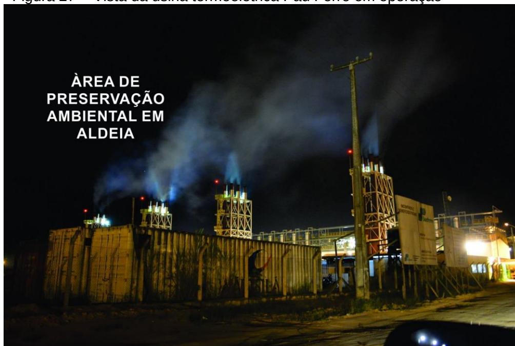
Figura 27 - Vista da usina termoeletrica Pau Ferro em operação
