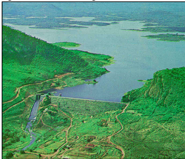
Figura 18 - Reservatório Engenheiro Ávidos/PB.
