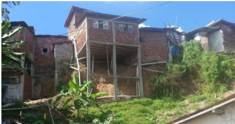
Figura 62 - Ocupação Desordenada, Lançamento de Águas Servidas no Solo e Casas Sobre Taludes Quase Verticais na Comunidade Santa Clara.
