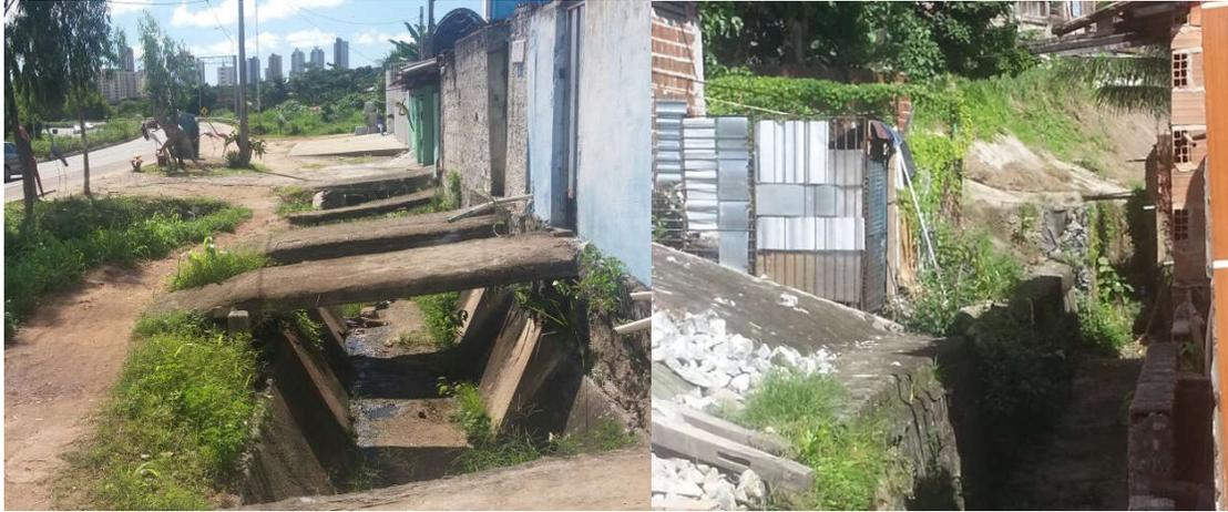
Figura 16 - Sistema de Drenagem da Comunidade (a Céu Aberto) com Recebimento de Águas Servidas.
