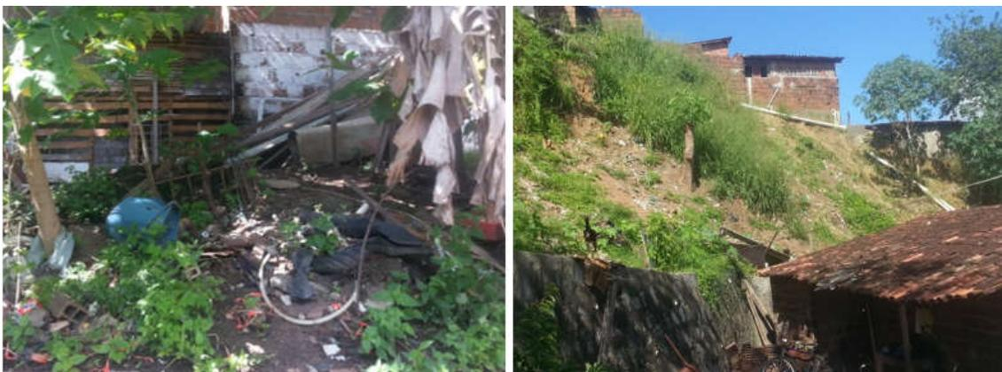
Figura 63 – Acúmulo de Lixo e Remoção da Vegetação Primitiva do Talude.
