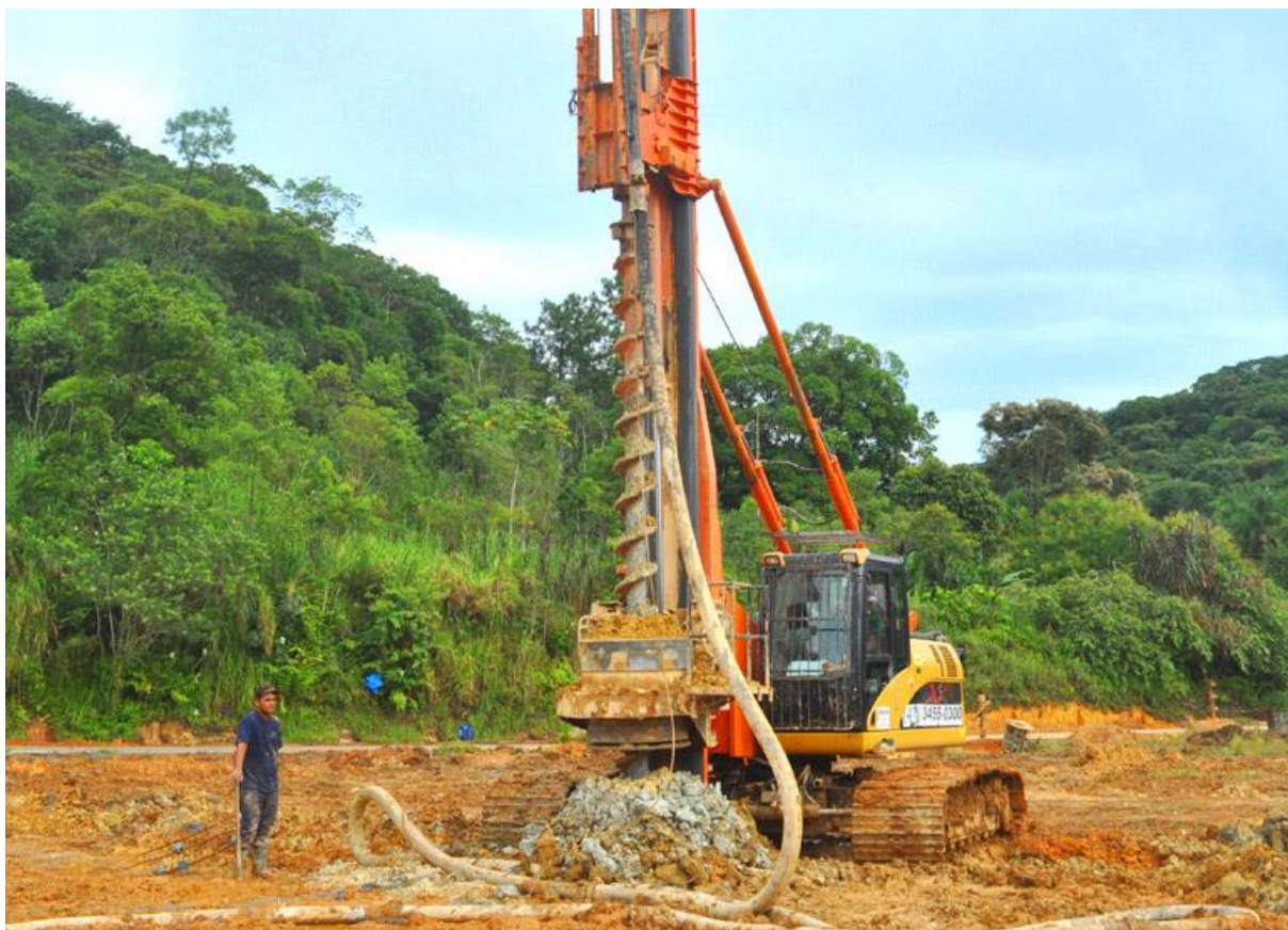
Figura 11 - Execução da estaca HCM 12
