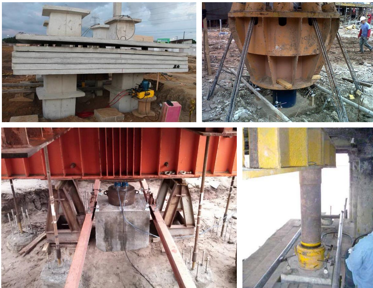
Plataforma cargueira (esquerda superior); Tirantes tipo cordoalha (direita superior); Estacas com monobarras de aço (esquerda inferior); Superestrutura da obra como reação (direita inferior).
