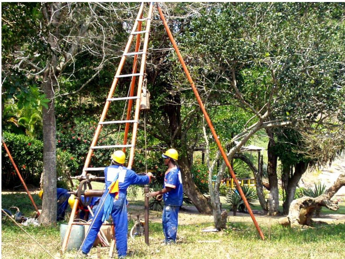
Figura 4 - Sistema manual de sondagem SPT 4
