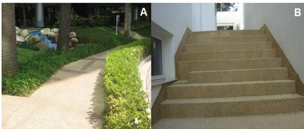
Figura 43: Aplicação de material britado em piso na forma de Fulget.
