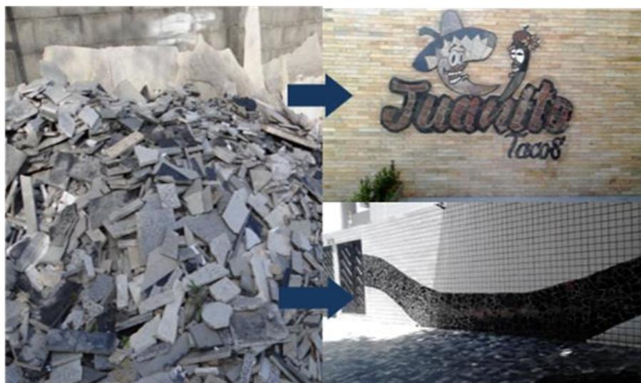
Figura 40: Aplicação de cacos e aparas em painéis verticais (logomarca e parede de edifício)
