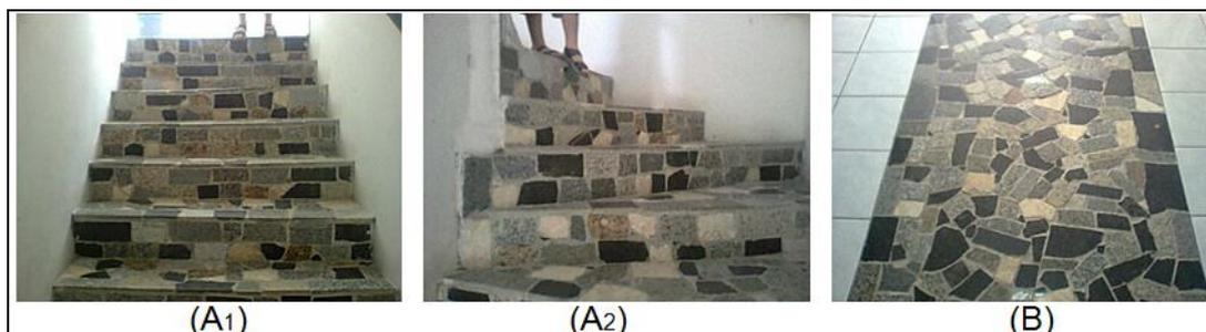
Figura 18: Fragmentos irregulares utilizados no revestimento de escadaria e pisos.
