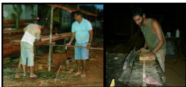
Figura 31: Corte de madeiras com serra circular manual e de mesa Fonte: O autor, 2012
