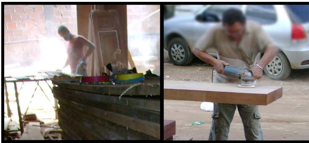
Figura 32: Uso de lixadeira para acabamento.
