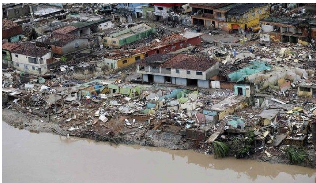
Figura 69 - Ampla destruição provocada pela enchente do rio Una, em Barreiros (PE). A enchente foi determinada pelo evento extremo de chuvas, em 17 de junho de 2010.
