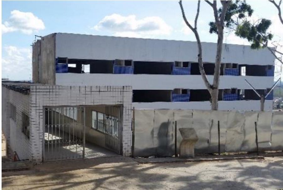
Fotografia 14 - Campus Garanhuns: Novo prédio de salas de aulas, em construção.
