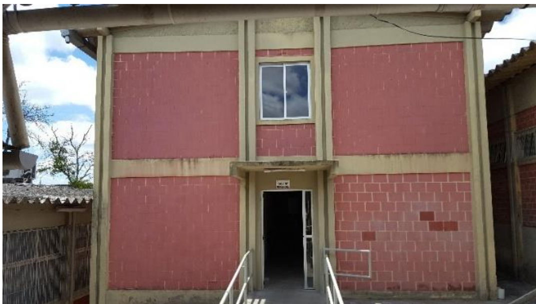
Fotografia 6 - Campus Garanhuns – Prédio das salas dos professores.
