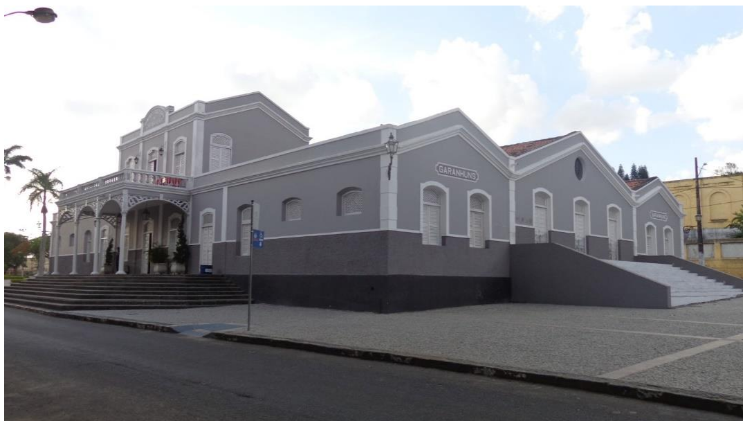
Figura 5 – Centro Cultural Alfredo Leite Cavalcanti de Garanhuns/PE, antiga Estação Ferroviária, 2013.
