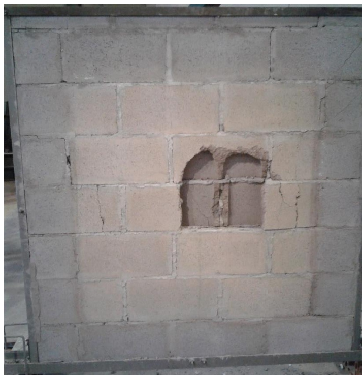
Foto 46 - Face Exposta ao Aquecimento da Parede 2 Após Ensaio Térmico e de Choque Mecânico
