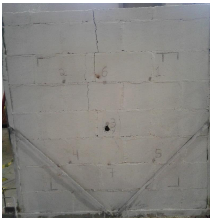
Foto 50 - Face Não Exposta ao Aquecimento da Parede 3 Após Ensaio Térmico e de Choque Mecânico
