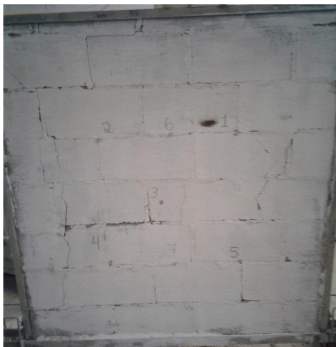
Foto 47 - Face Não Exposta ao Aquecimento da Parede 2 Após Ensaio Térmico e de Choque Mecânico
