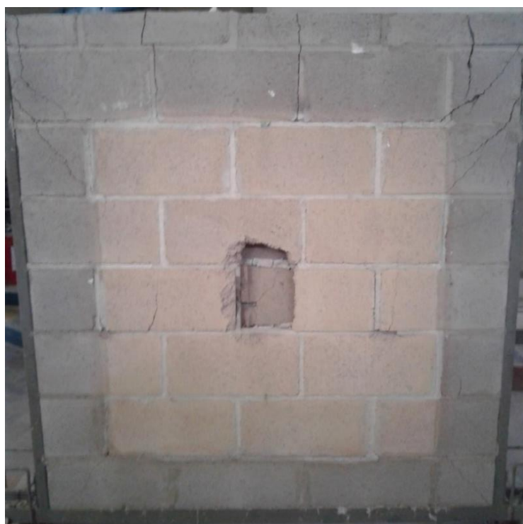
Foto 45 – Face Exposta ao Aquecimento da Parede 1 Após Ensaio Térmico e de Choque Mecânico
