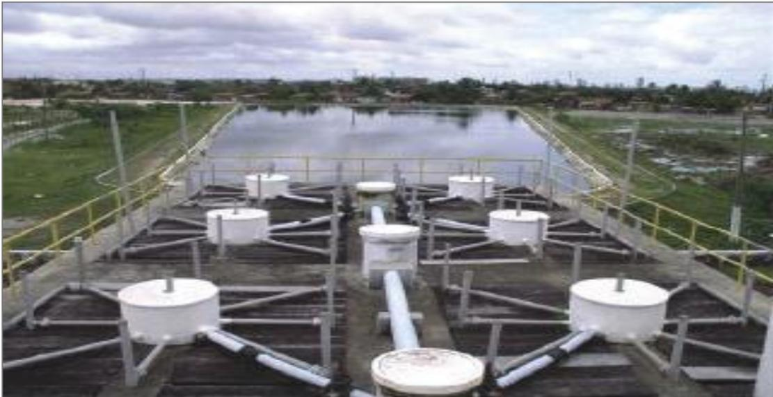
**Figura 03.** Reator anaeróbico de fluxo ascendente (UASB) da ETE Mangueira.
