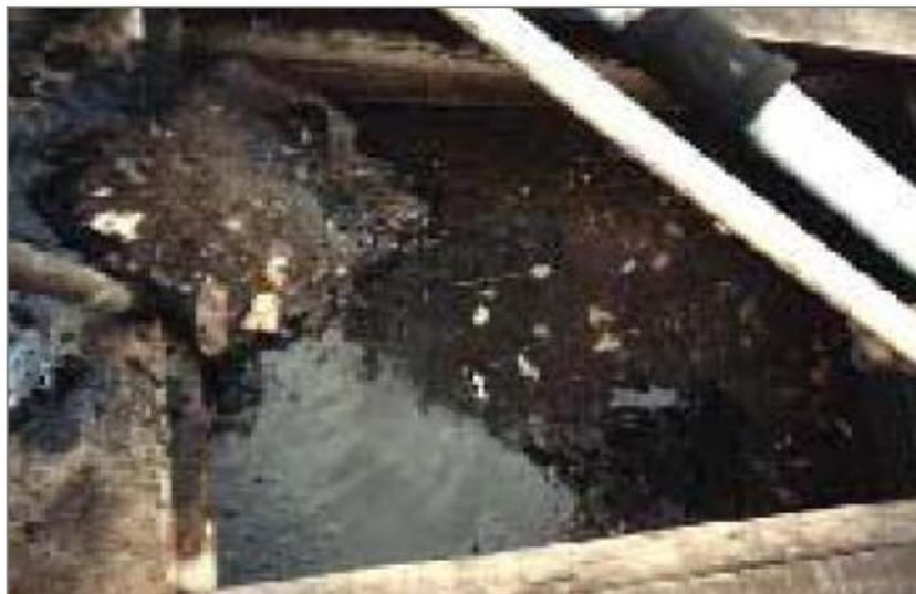
**Figura 05.** Retirada da camada de espuma de uma das 8 células do reator UASB da ETE Mangueira. Fonte: Silva, 2001.
