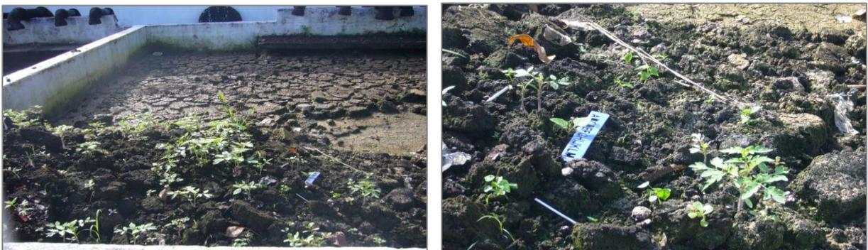
**Figura 06.** Desenvolvimento de vegetação nos leitos de secagem da ETE Mangueira.
