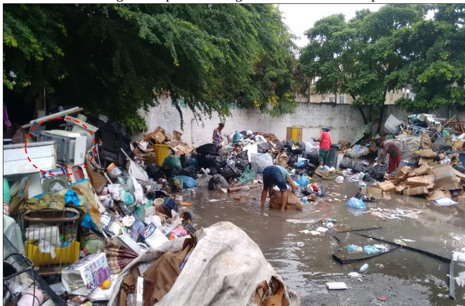
Figura 9 – Falta de drenagem em pátio de triagem de resíduos na cooperativa Recicla Torre
