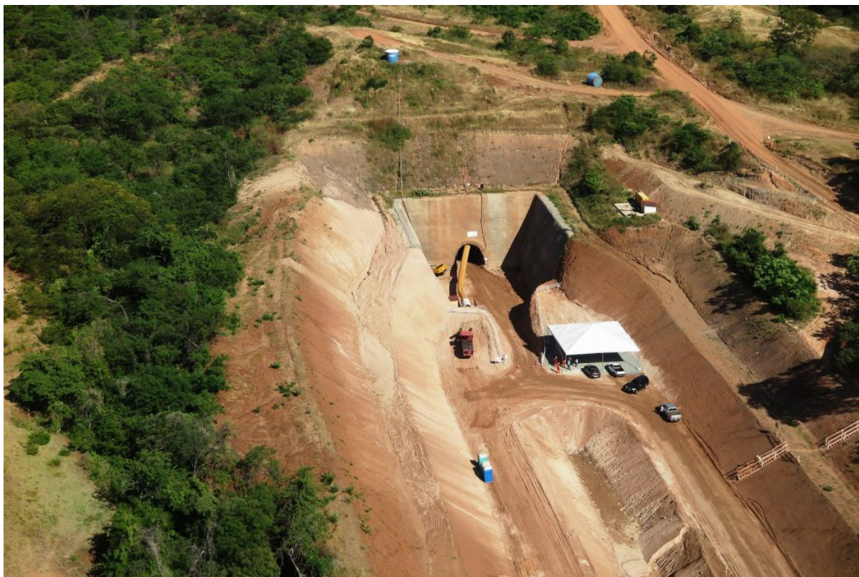
Figura 19 Obra do Túnel Veneza, no Trecho I, do Cinturão de Águas do Ceará
