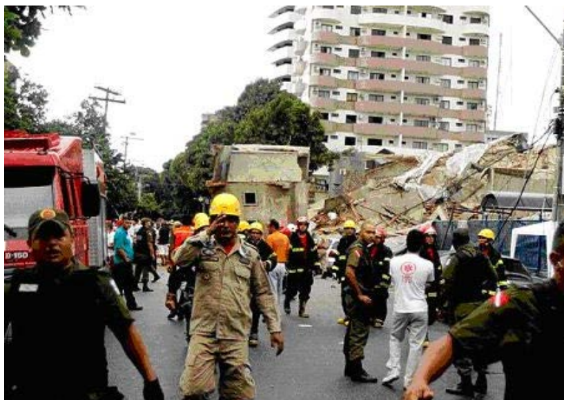
Figura 3 Desabamento de edifício - Belém
