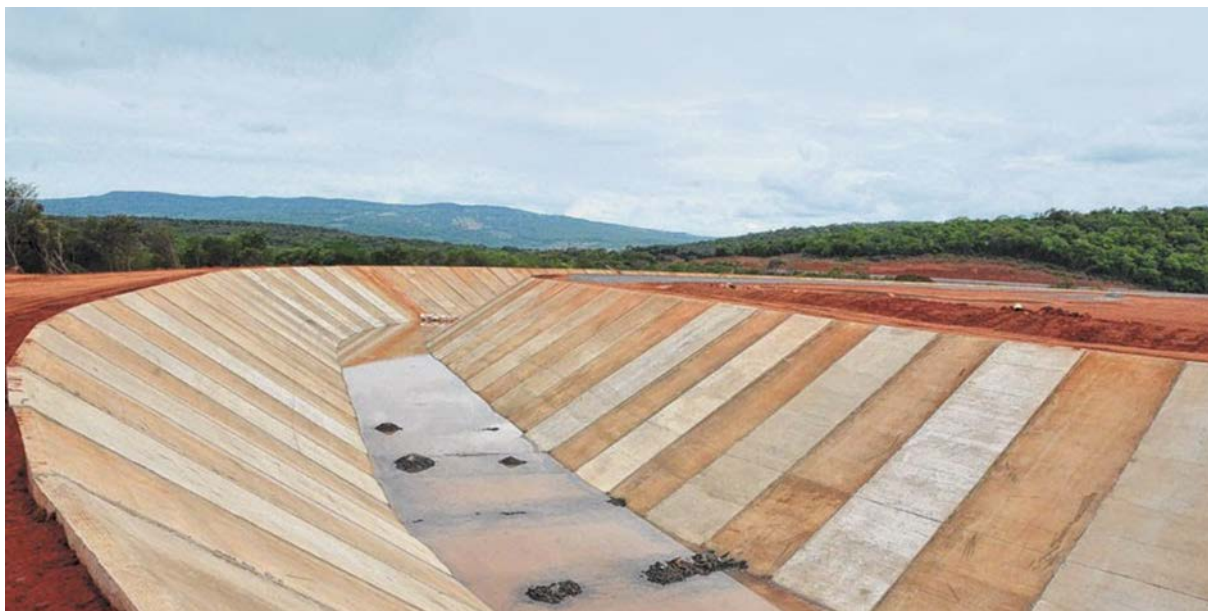
Figura 18 Obra de canal, no Trecho 1, do Cinturão de Águas do Ceará
