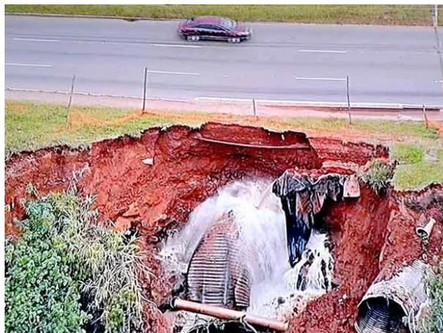
Figura 8 – Erosão decorrente de um vazamento de água.
