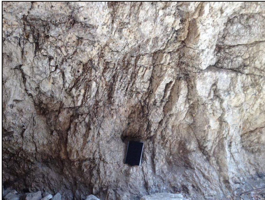
Figura 23 - Parede de lateral de galeria transversal ao pegmatito facheiro.
