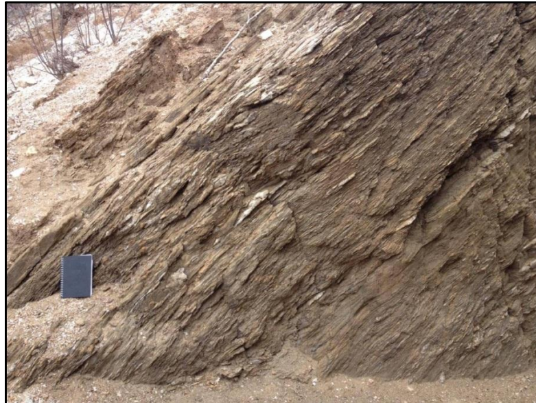
Figura 21 - Parede lateral de galeria escavada entre a rocha encaixante (vista na imagem) e o pegmatito Facheiro.
