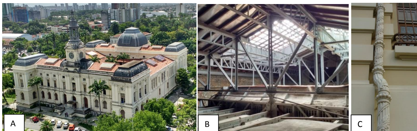
Imagem 5I: Detalhe da estrutura da edificação.
