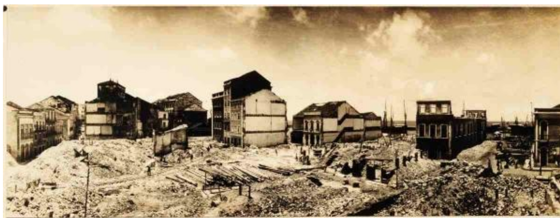
Imagens 10: Bairro do Recife, demolições, 1913- Auto: Benício Dias
