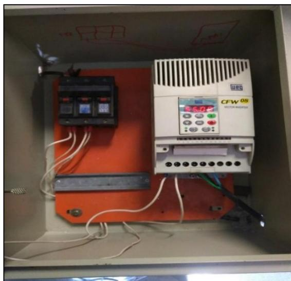
**Figura 24:** Inversor de frequência CFW-08.
