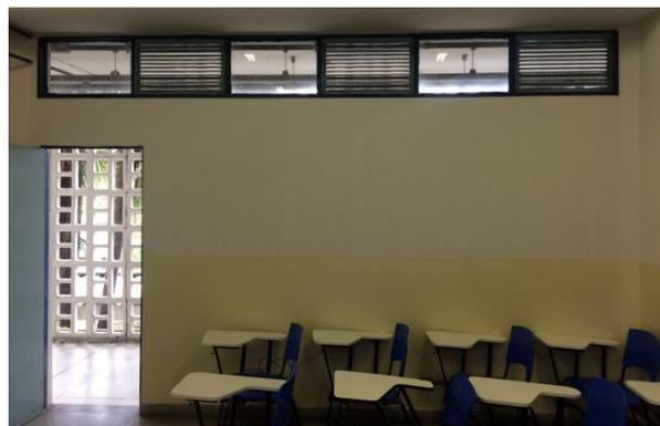
Figura 16- Sala pequena disposição 01 com janelas superiores de frestas abertas.
