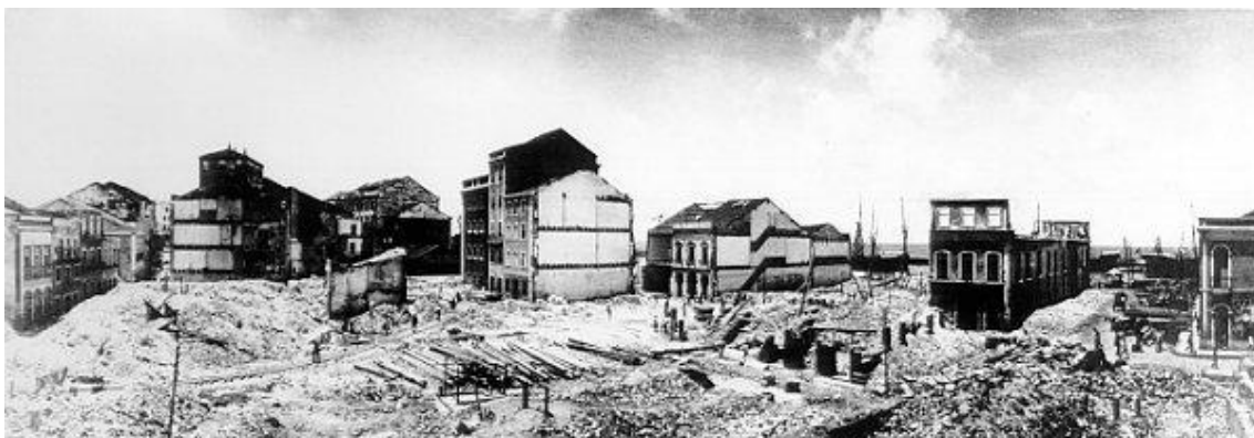
Figura 49 – Demolição dos quarteirões entre a Rua do Bom Jesus e o Pelourinho. Recife, 1913. Fotografia de Benício Whatley Dias.
