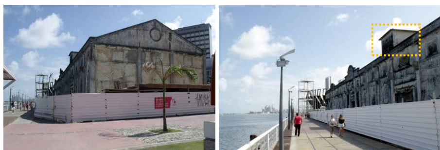
Figura 126 e 127 – Situação da edificação em 2015. Havia elemento construído sobre a coberta, em área lindeira à parte da fachada posterior – espécie de camarinha ou estrutura de caixa d'água; possivelmente não fosse contemporâneo ao edifício, uma vez que o projeto aprovado traz tal elemento suprimido, ao passo que inclui o coroamento de uma das portas, que também não se sabe ser original.
