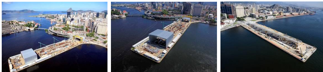
Figuras 08 a 10 – Fases da construção do Museu do Amanhã.
