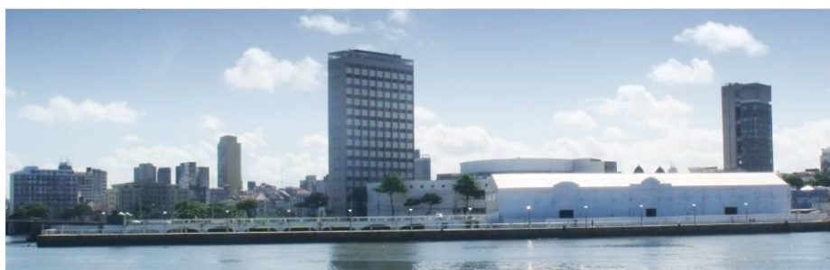
Figura 95 – Vista do conjunto estacionamento e armazém 14 (em obras).
