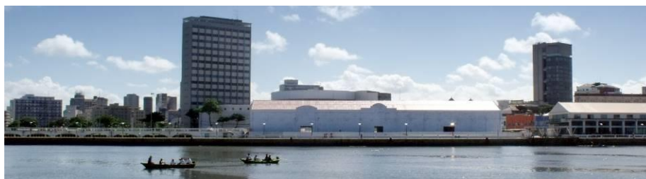
Figura 111 – Vista geral do Armazém 14.
