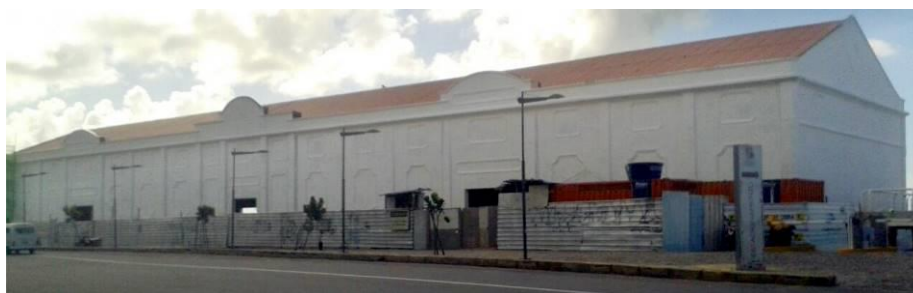
Figuras 122 – Armazém 14, aparentemente, no processo final de intervenção. Vista desde a Avenida Alfredo Lisboa.
