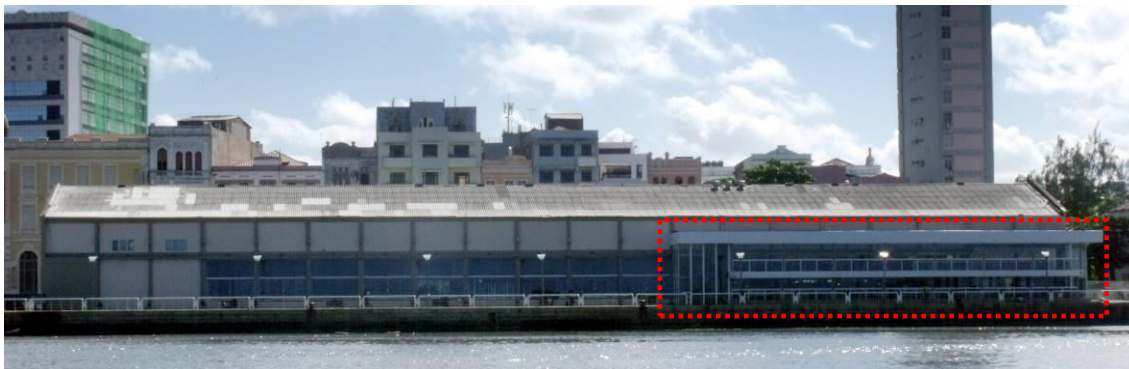
Figura 167 – Armazém 11; destaque para alterações de fachada, com substituição de alvenaria por vidro, e inserção de volume, composto por material metálico e vidro, sacando da linha original da edificação onde funciona o primeiro restaurante e bar das novas reformas do porto.
