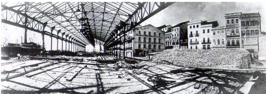
Figura 50 – Construções dos armazéns do porto. Recife, 1914. Fotografia de Benício Whatley Dias.
