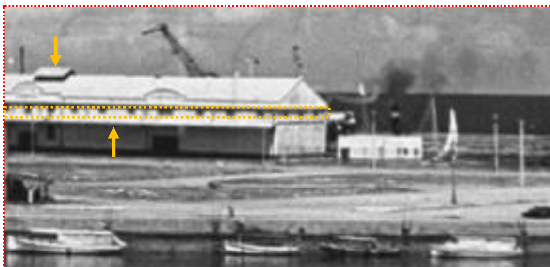
Figura 92 – Armazém 14 e seu entorno imediato. Na edificação são observados dois elementos suprimidos – lanternim e passeio coberto; e o entaipamento dos vãos superiores. A área de entorno imediato não era construída. Foto: Hart Preston.
