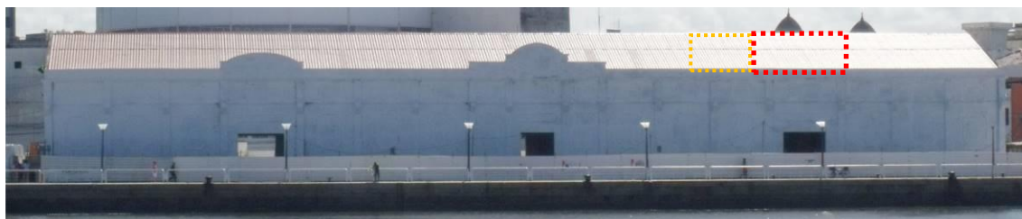
Figura 125 – Armazém 14, aparentemente, no processo final de intervenção. Comparando-se o projeto com o executado, percebe-se que um dos coroamentos dos vãos de porta não existe; o elemento anteriormente construído sobre a coberta foi suprimido.
