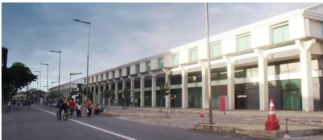
Figura 142 – Fachada Frontal (Noroeste) do Armazém 13. Parte da edificação em funcionamento.
