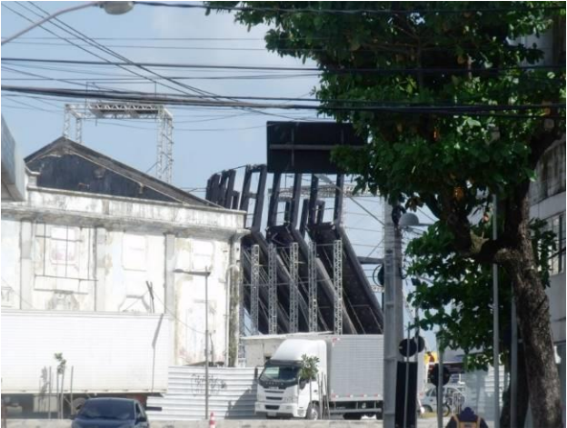
Figuras 104 e 105 – Estrutura armada para realização de show privado; e estacionamento em meio subsolo, recoberto por estrutura de laje, que serve como estacionamento e para eventos. Fonte: a autora, out. 2015. jun.2016.
