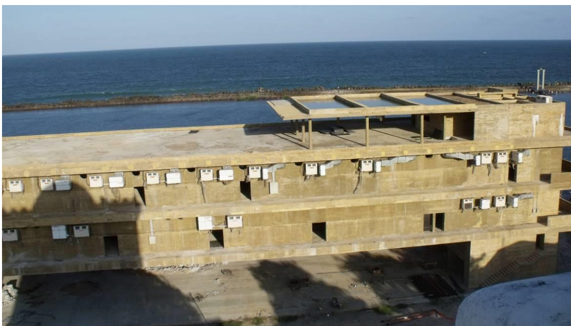
Figura 187 – Vista da coberta da edificação, de cima da Torre Malakoff. Nota-se que a edificação ainda não foi concluída.
