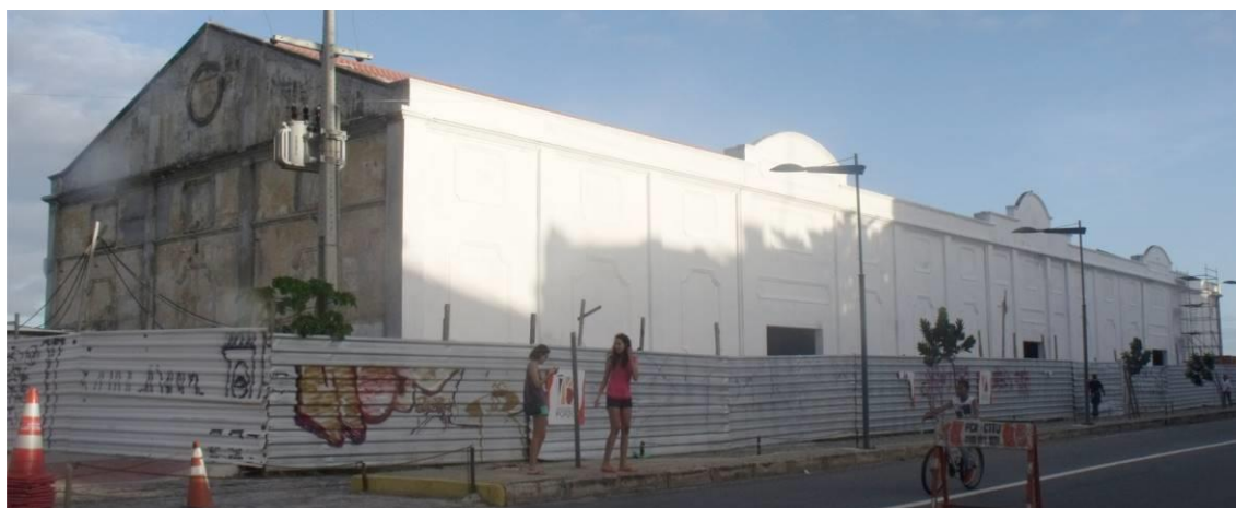
Figura 123 – Armazém 14, aparentemente, no processo final de intervenção. Vista desde a Avenida Alfredo Lisboa.
