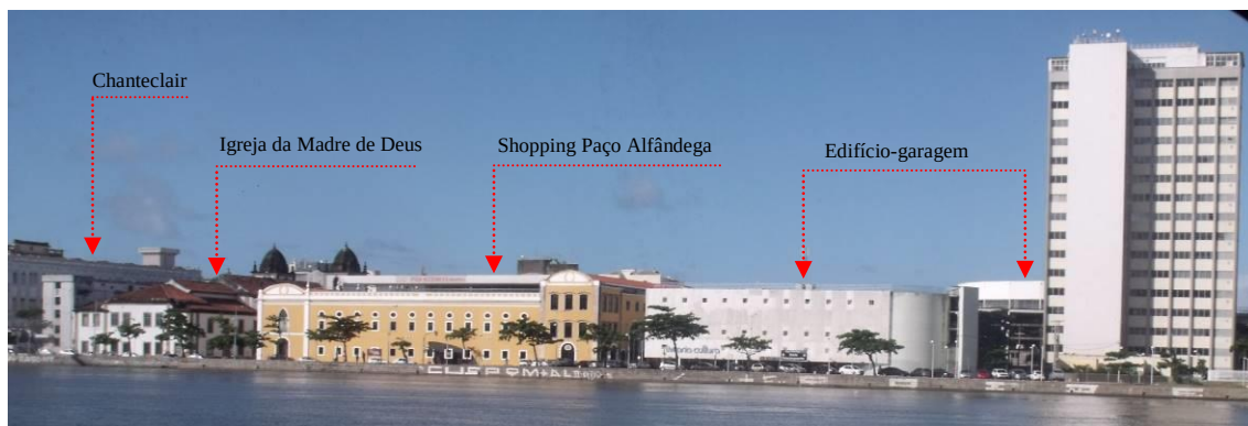
Figura 52 – da esquerda para a direita - Igreja da Madre de Deus, Shopping Paço Alfândega , e o módulo do edifício-garagem, que abriga a livraria Cultura, vistos desde a Avenida Martins de Barros, no bairro de Santo Antônio.
