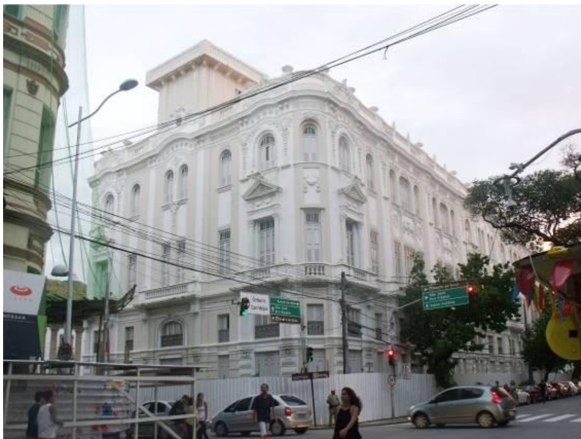
Figura 56 – Edificação do antigo Chanteclair parcialmente restaurada.
