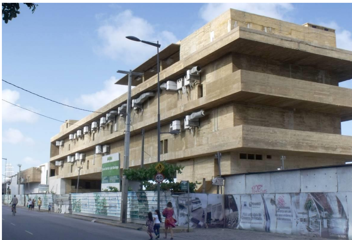
Figura 185 – Em primeiro plano, a tipologia contemporânea; em segundo a tipologia similar aos armazéns originais.
