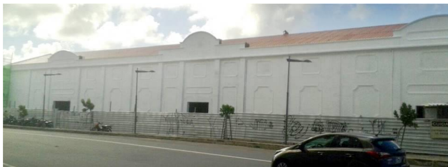
Figura 112 – Vista geral do Armazém 14.
