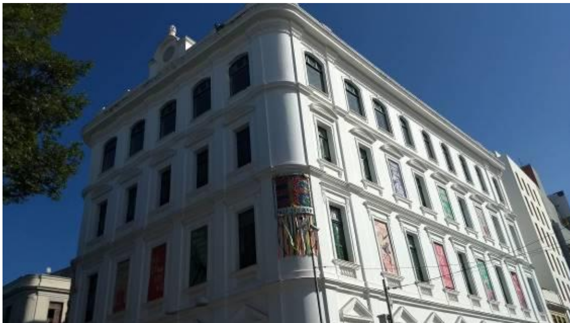
Figura 57 – Edificação da antiga Western Telegraph Company , atualmente abriga o equipamento cultural, Paço do Frevo.
