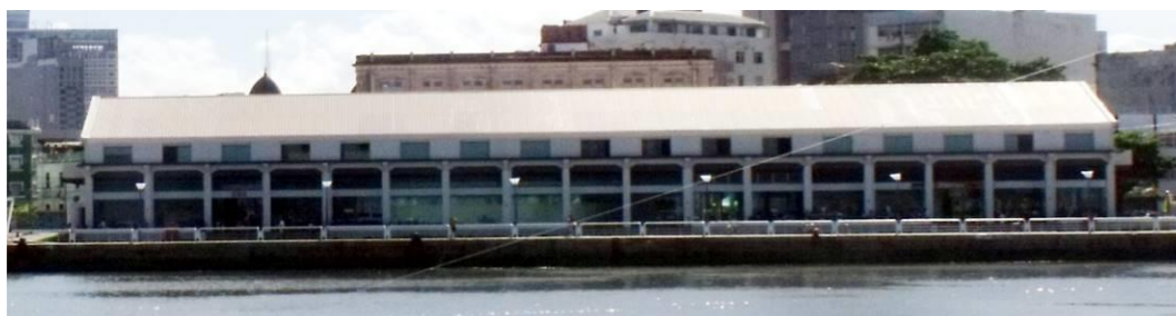
Figura 144 – Fachada Posterior (Sudeste) da edificação.
