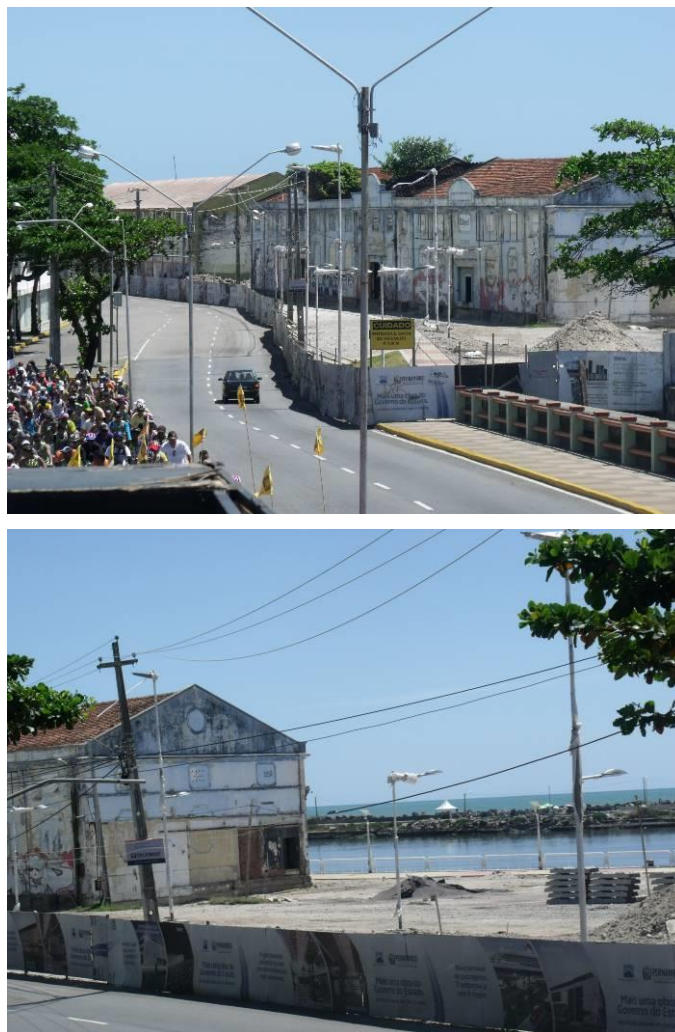
Figuras 100 e 101 – Provável início das obras do atual estacionamento.
