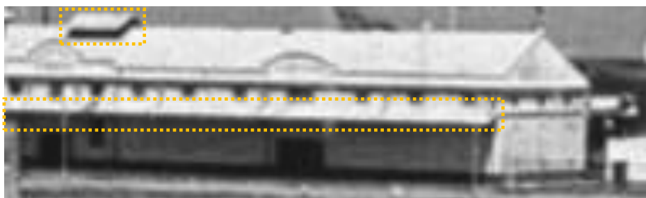
Figura 113 – Supressão do lanternim na coberta e da segunda coberta da fachada frontal. Foto: Hart Preston.
