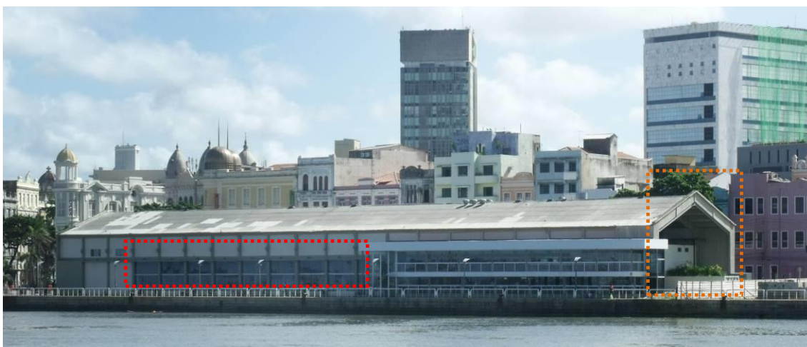
Figura 168 – Armazém 11; destaque para alterações de fachada – substituição de alvenaria por vidro. A fachada lateral esquerda perdeu o seu fechamento em alvenaria, o que criou um espaço de transição entre área interna e externa.
