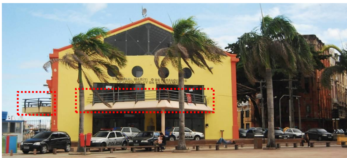
Figura 146 – Edificação com intervenções à época em que abrigou o Terminal Marítimo de Passageiros. A fachada lateral esquerda possuía varanda, e portas, janelas e óculos envidraçados. Na fachada posterior havia pequenas varandas.
