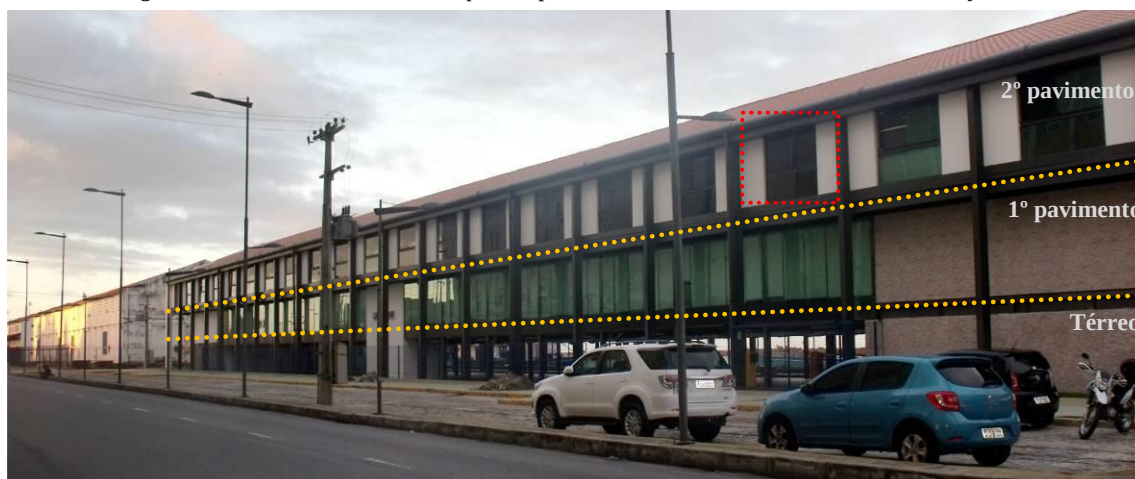
Figura 203 – Fachada frontal, destaque aos pavimentos criados e à forma da abertura da janela.
