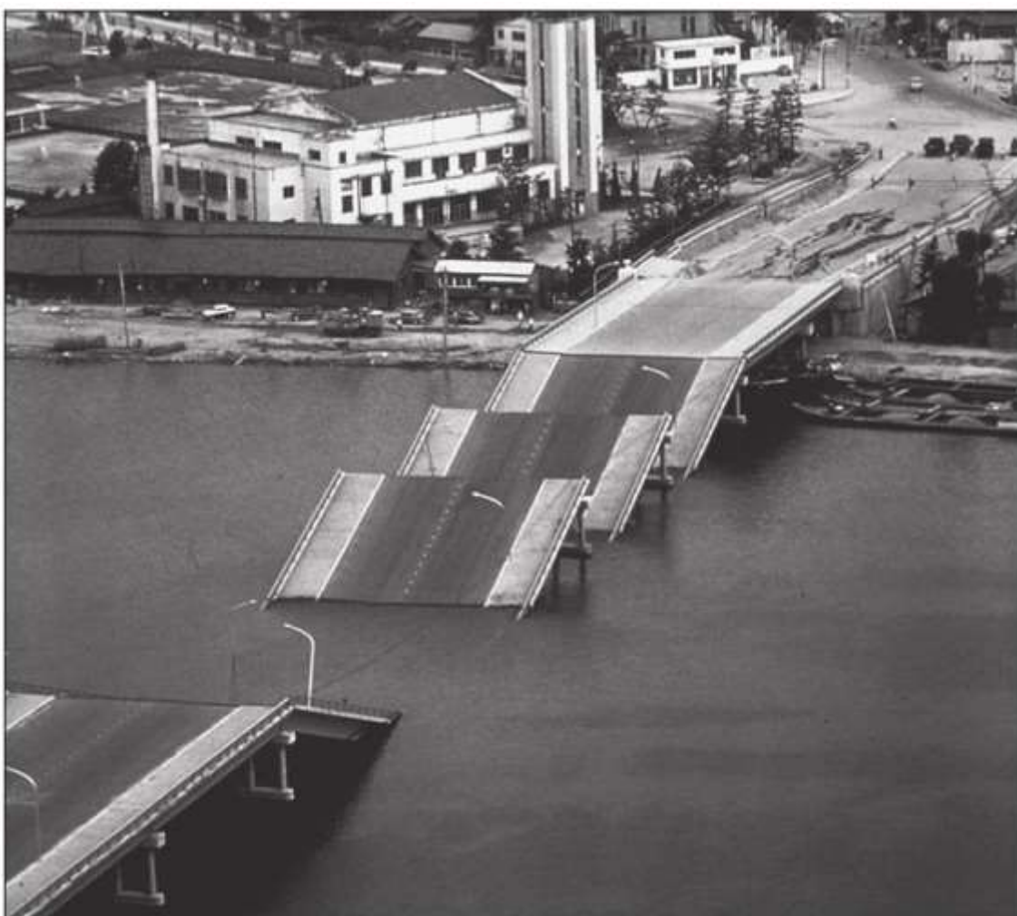
Figura 8 - Colapso de uma ponte composta de vigas sobre apoios simples durante o terremoto de 1964 ocorrido em Niigata, Japão, (Kenneth et al, 2009).
