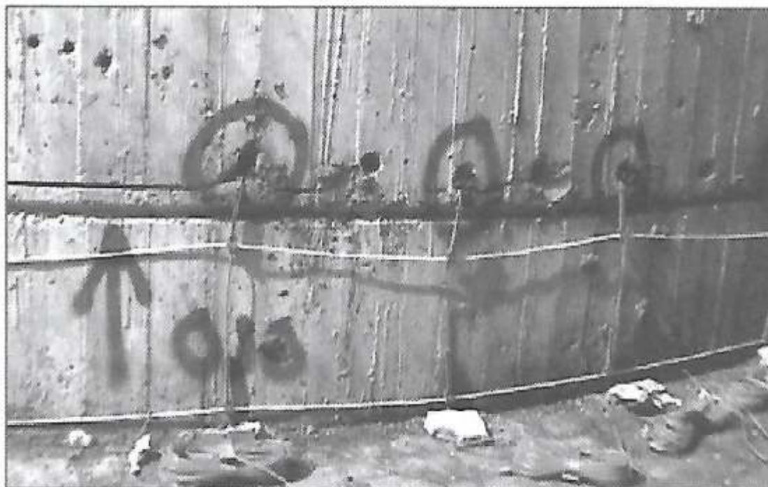
Figura 19 - Cordel detonante conectando cargas explosivas acondicionadas em furos feitos na base de uma chaminé de concreto armado que será demolida (FUENTES, 2011).
