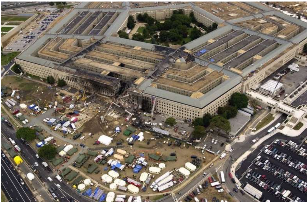
Figura 13 - Imagem do edifício do Pentágono, nos Estados Unidos, após o atentado de 11 de setembro de 2001 (NISTIR – 7396, 2007).
