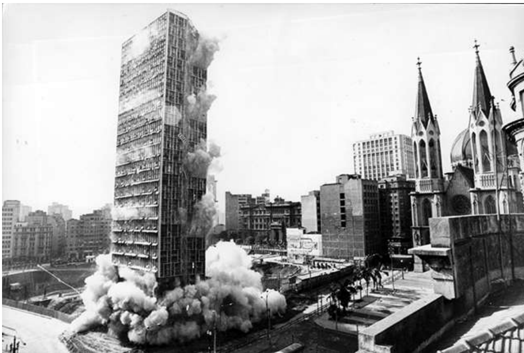
Figura 2 - Implosão do Edifício Mendes Caldeira, São Paulo, 1975.
