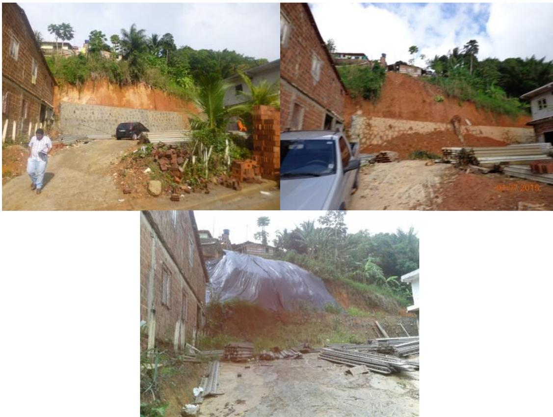
Figura 4.7: Fotos da região onde houve uma ruptura de talude.
