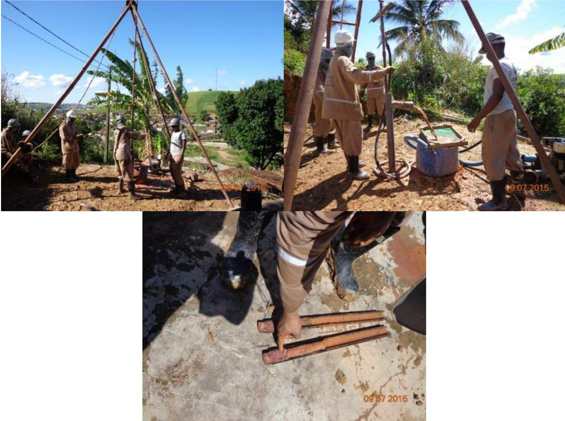
Figura 4.14: Sondagem SP-01 (Meio da encosta).
