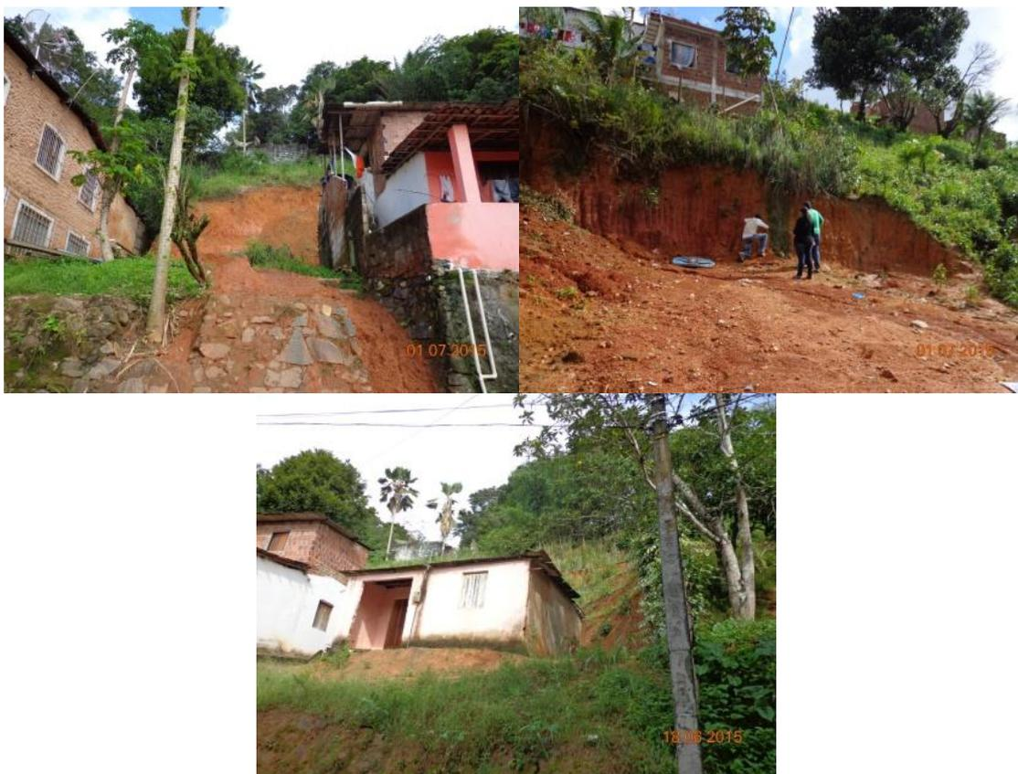
Figura 4.8: Fotos de cortes feitos pelos moradores nos taludes.
