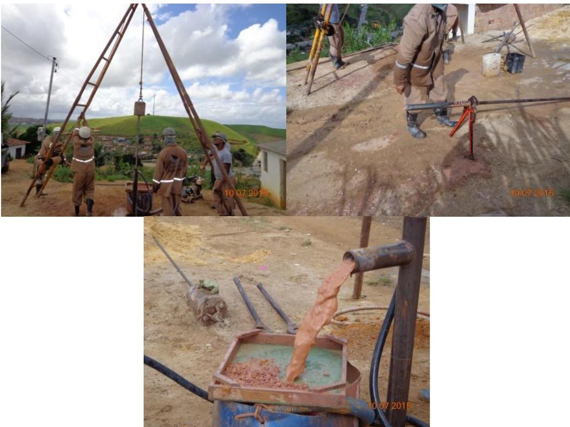
Figura 4. 15: Sondagem SP-02 (Topo da encosta).
