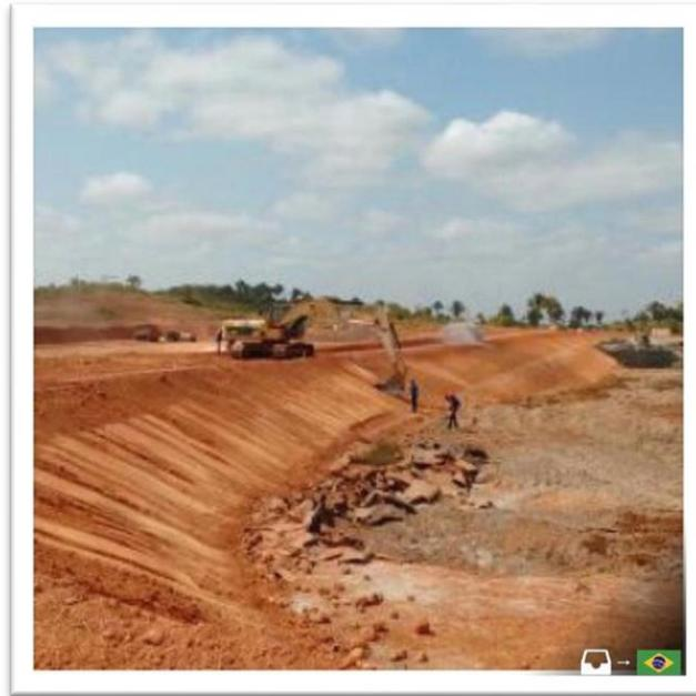
Figura 2.4: Exemplo de um talude de aterro.
