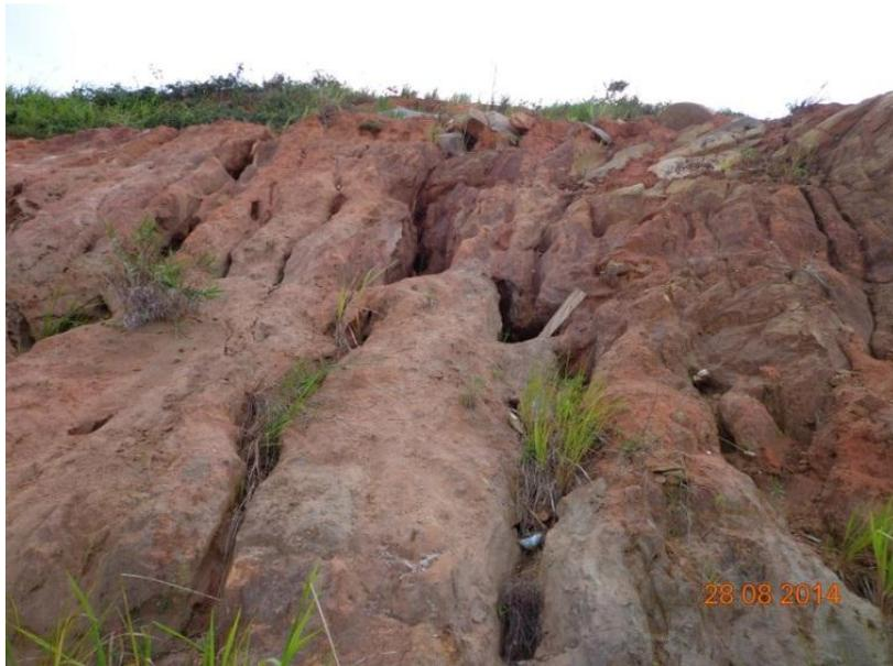
Figura 2.24: Erosões provocadas por chuvas intensas no município de Moreno/PE.
