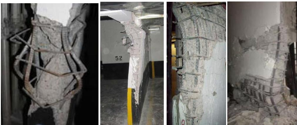
Figura 1.12. Rupturas típicas de pilares-parede ocorridas nos terremotos do Chile e da Nova Zelândia (adaptado de Wallace e Moehle)
