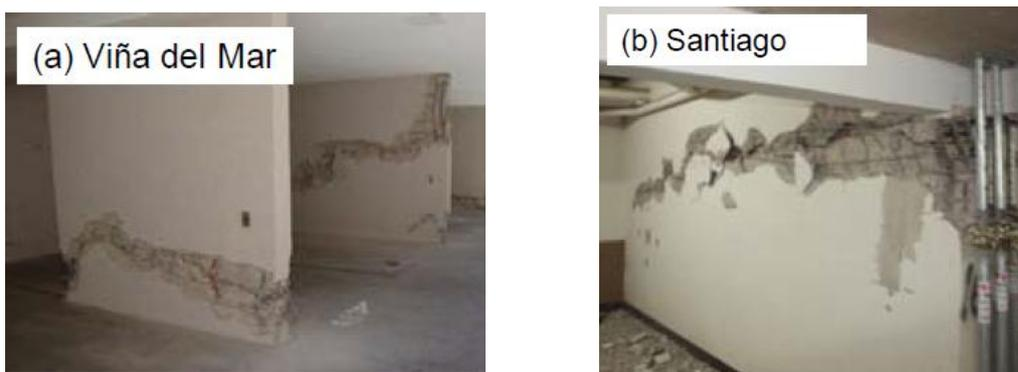
Figura 1.11. Rupturas típicas de pilares-parede ocorridas nos terremotos do Chile e da Nova Zelândia (adaptado de Wallace e Moehle, 2012)
