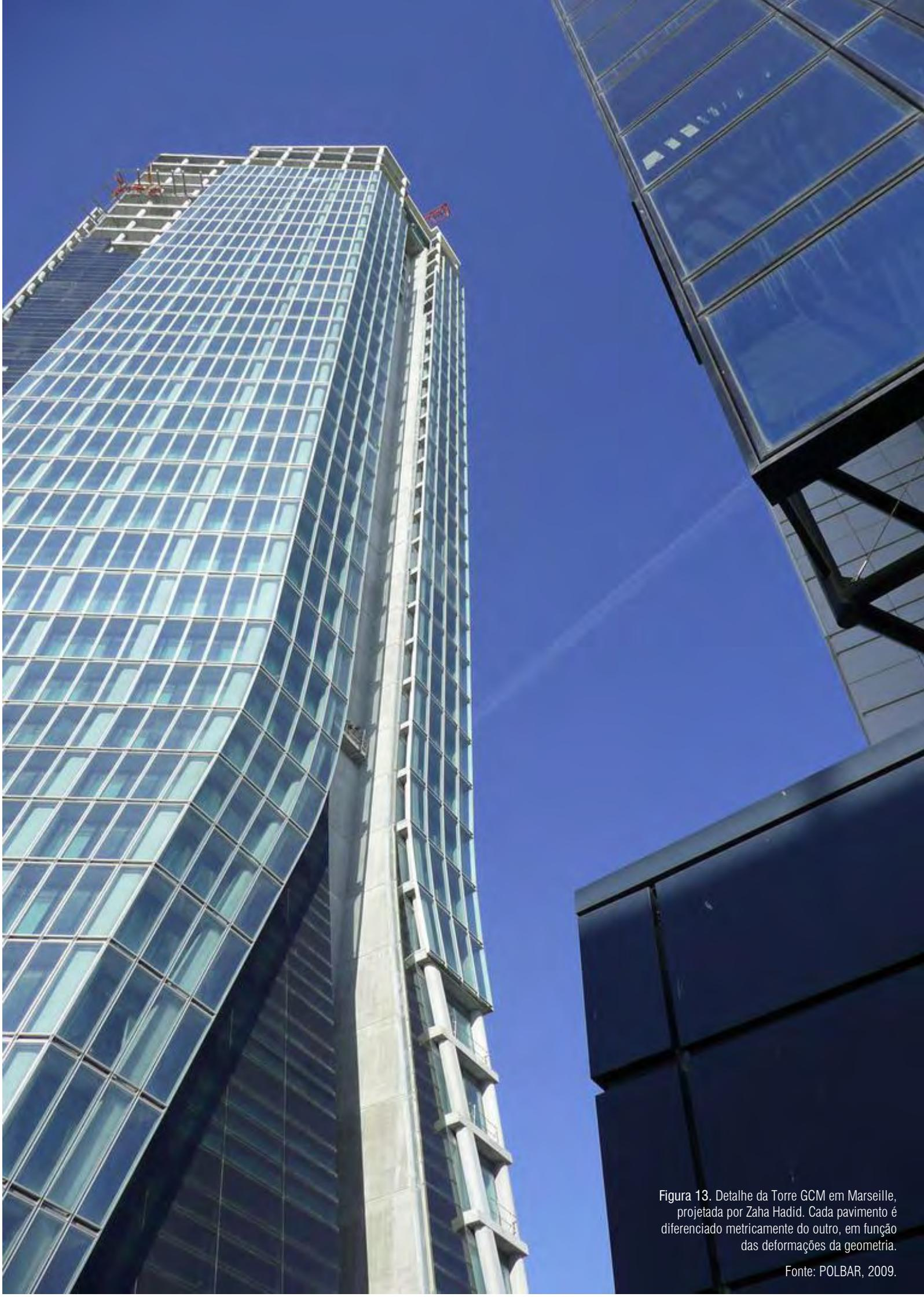
Figura 13. Detalhe da Torre GCM em Marseille, projetada por Zaha Hadid. Cada pavimento é diferenciado metricamente do outro, em função das deformações da geometria.
