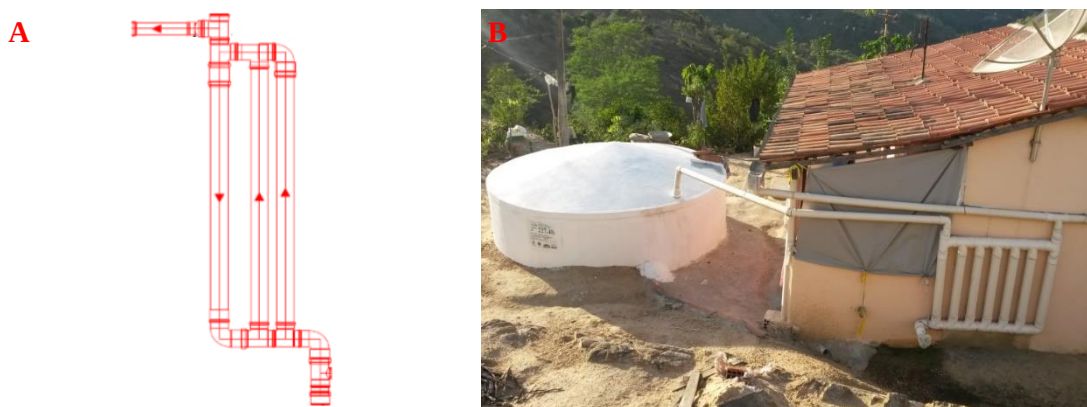
Figura 4 – Esquema do DesviUFPE (A) e DesviUFPE instalado no semiárido pernambucano (B).
