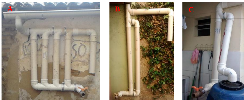
Figura 10 – Fotografia dos DesviUFPE instalados na área industrial de Belo Jardim: ponto de coleta é uma borracharia e o DesviUFPE tem capacidade de acúmulo de 25,5 L (A), ponto de coleta é uma residência e o DesviUFPE tem capacidade de acúmulo de 24,4 L (B) e ponto de coleta é residência e o DesviUFPE tem capacidade de acúmulo de 8,3 L (C).
