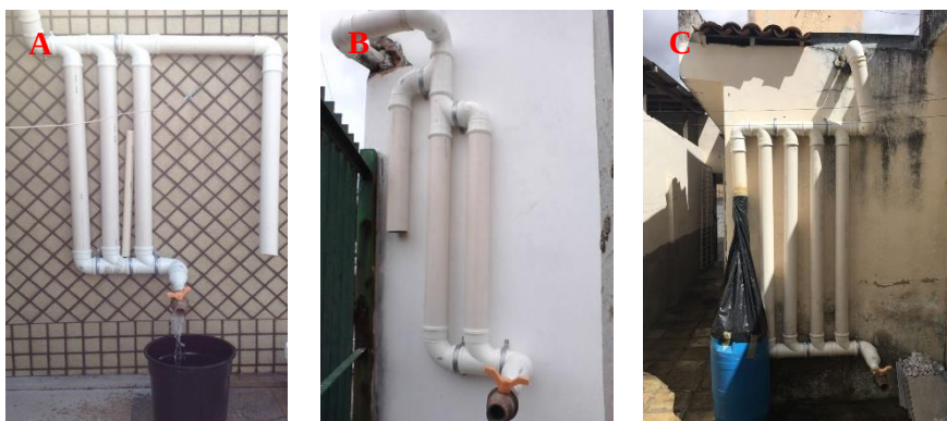
Figura 9 – Fotografia dos DesviUFPE instalados na área urbana de Caruaru: ponto de coleta é residência e o DesviUFPE tem capacidade de acúmulo de 29,2 L (A), ponto de coleta é um prédio público e o DesviUFPE tem capacidade de acúmulo de 13,9 L (B) e ponto de coleta é residência e o DesviUFPE tem capacidade de acúmulo de 51 L (C).
