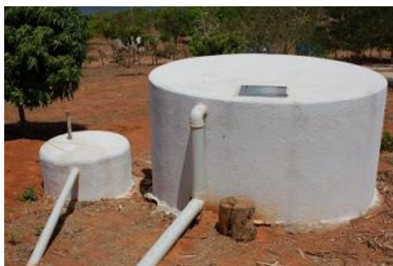
Figura 2 - Detalhe dos dois tanques que compõem a cisterna com sistema de boia.
