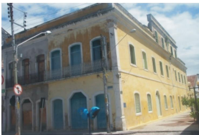
IMAGEM 2 IMÓVEL 181 (RUA DO APOLO) ANTES DA CHEGADA DO PORTO DIGITAL
