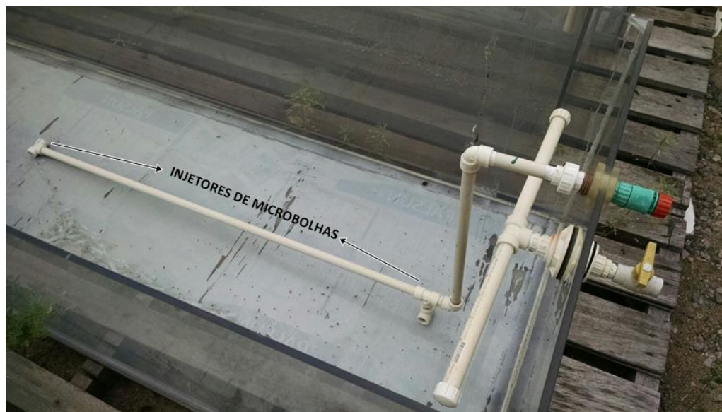
Figura 10 - Injetores de microbolhas instalados na base do wetland construído
