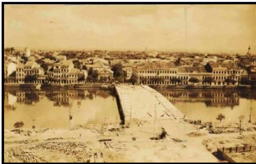
**Figura 4:** Construção da Ponte Duarte Coelho. Do outro lado da margem a ainda Rua Conde da Boa Vista. Fonte: FUNDAJ (Vila Digital). Autor: Benício Whatley Dias.
