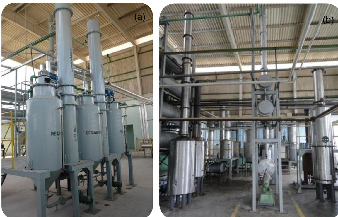
Figura 16 - Reatores de produção de biodiesel (a) e Colunas de destilação (b) da usina de Caetés/PE.
