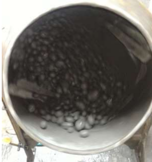
Figura 16 (4): Fim do procedimento de mistura do concreto.
