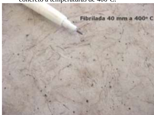
Figura 7 (3): Canais deixados pelas fibras de polipropileno fibriladas após a exposição do concreto a temperaturas de 400°C.
