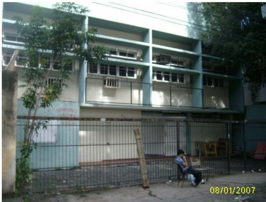
Figura 5 - Fachada atual do Prédio do SEC
