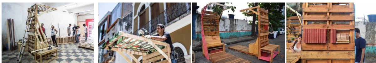
Figura 4.16 Processo de construção dos Abrigos Bibliotecas no Workshop Internacional Urban Labs . 32
