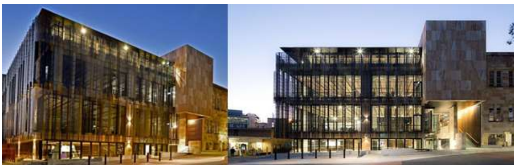
Foto 1 - Primeiro edifício estrutural com concreto geopolimérico
