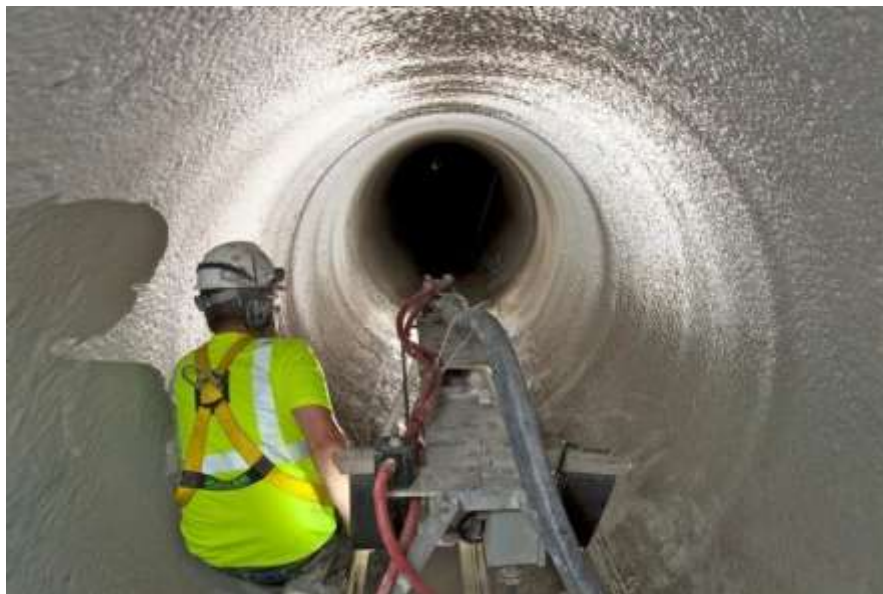
Foto 3 - Tubos de esgoto reparados com spray de geopolímero
