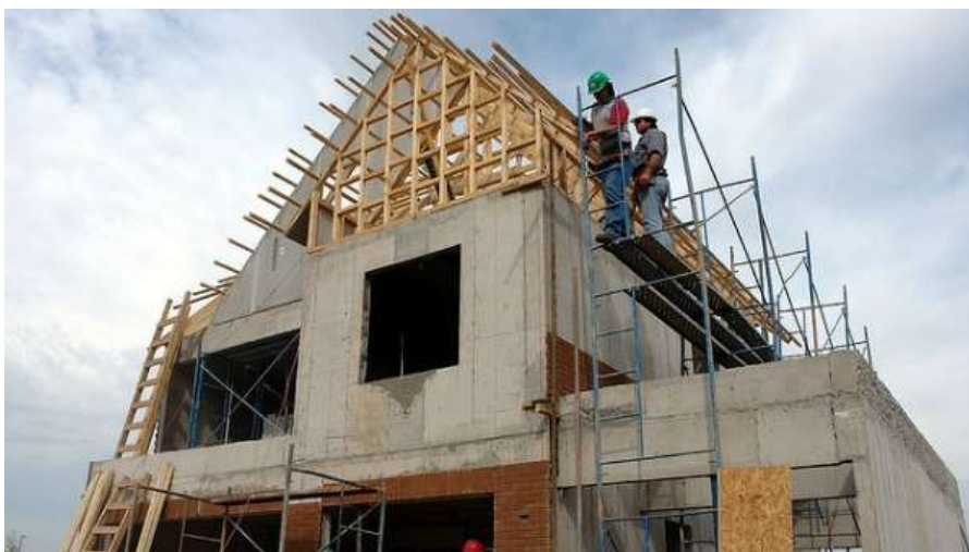
Foto 4 - Painéis de geopolímeros reforçado com malha de aço
