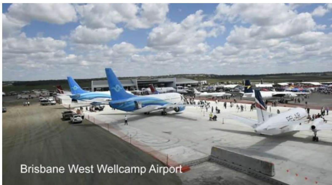
Foto 2 - Aeroporto na Austrália construído com concreto geopolimérico
