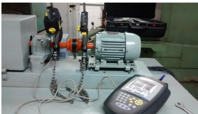
Figura 2.9: Montagem do Alinhador a Laser
