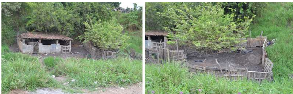
Figura 19- Pocilga às margens do anel viário, entre Cabelão e Cacimba da Rosa.
