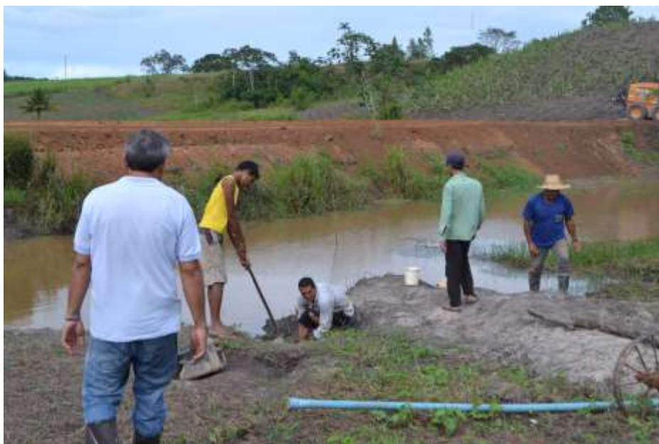
Figura 15- Construção do barramento no assentamento Fazendinha, próximo à nascente Cacimba 1. Fonte: Arquivo pessoal, 2016.
