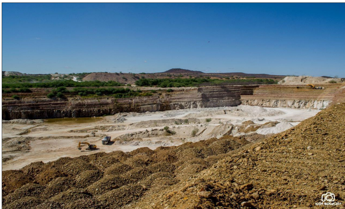
Figura 47: Reabilitação da cava pelo método Terrace Mining em 2017
