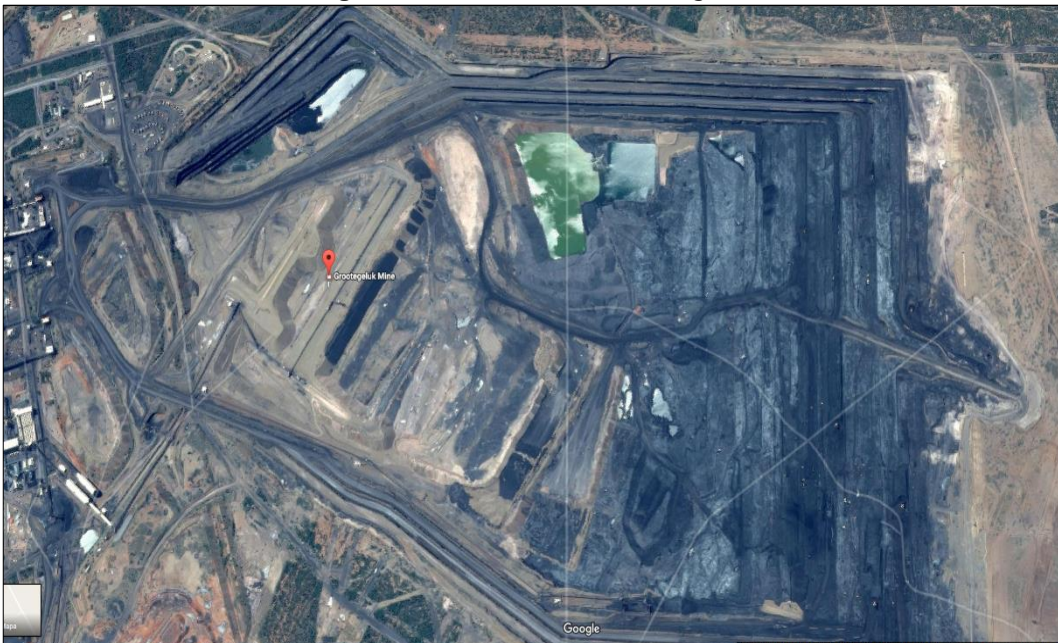
Figura 27: Mina de Carvão Grootegeluk
