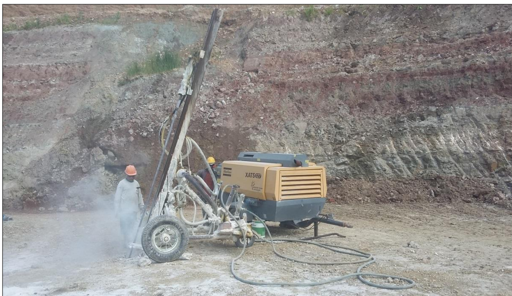
Figura 35: Operação unitária de perfuração
