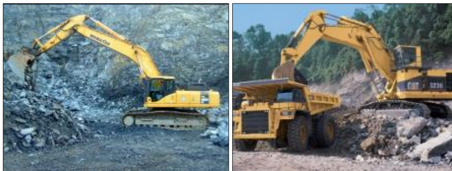
Figura 7: Operação de carregamento com escavadeira
