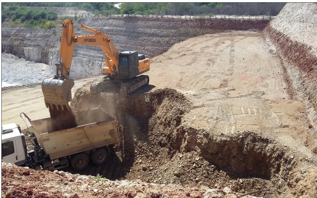
Figura 33: Operação de carregamento do material estéril (decapeamento)
