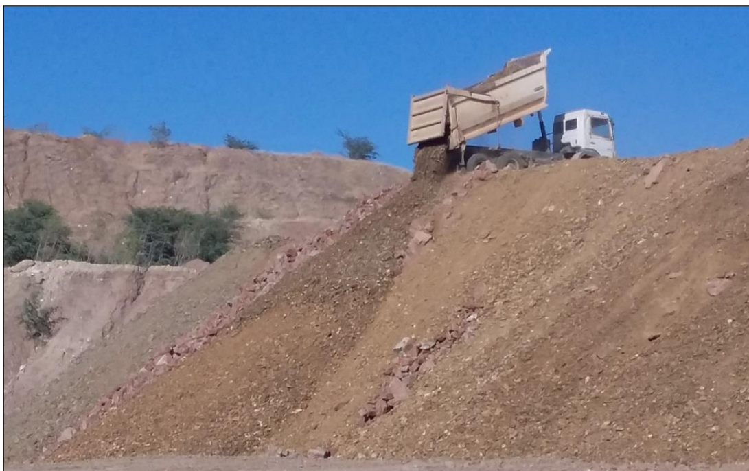
Figura 34: Disposição do material estéril na cava minerada
