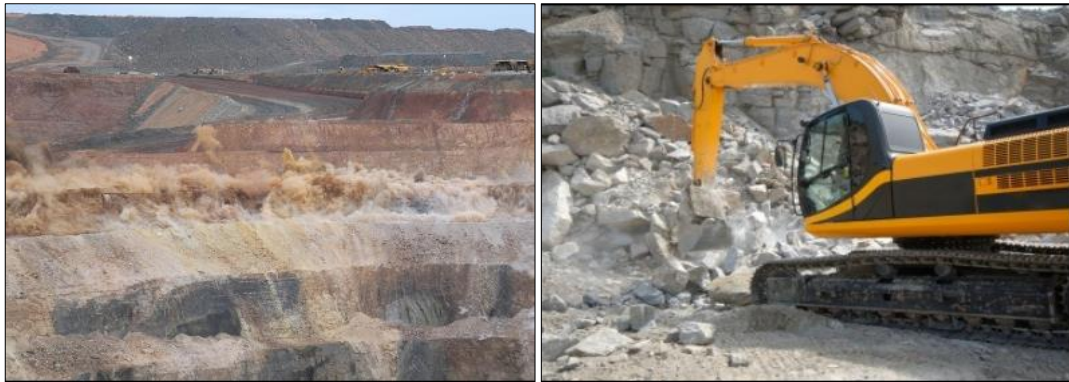
Figura 5: Operação de desmonte com explosivos e desmonte mecânico
