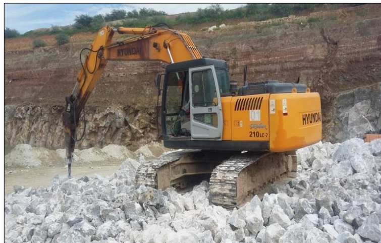
Figura 6: Operação de desmonte secundário com martelo hidráulico
