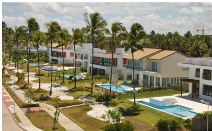
Figura 28: Condomínio Morada da Península no Bairro Planejado Paiva Fonte: Arquivo Pessoal (21 de abril de 2015)
