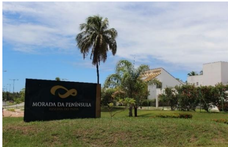
Figura 30: Condomínio Morada da Península no Bairro Planejado Paiva Fonte: Arquivo Pessoal (21 de abril de 2015)
