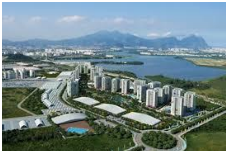
Figura 19: Ilha Pura, bairro planejado na Barra da Tijuca no Rio de Janeiro. Fonte: orealizacoes.com.br > Acesso em: 11 fev..2015.
