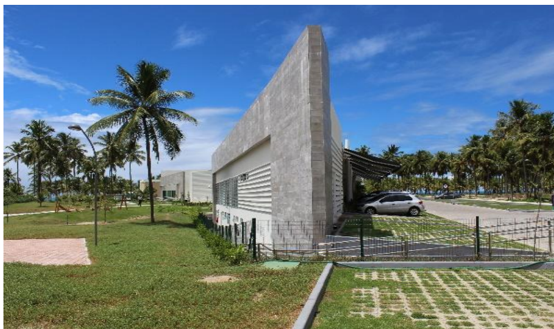
Figura 4: Acesso à praia do bairro planejado do Paiva Fonte: Arquivo Pessoal (21 de abril de 2015)
