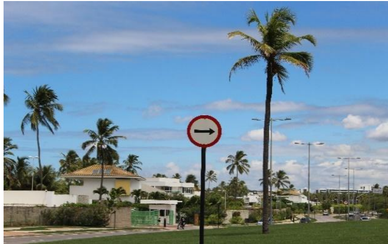
Figura 29: Condomínio Morada da Península no Bairro Planejado Paiva Fonte: Arquivo Pessoal (21 de abril de 2015)
