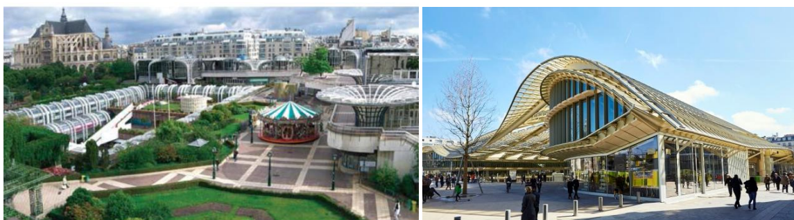
Figura 1 - Imagens da intervenção em Les Halles
