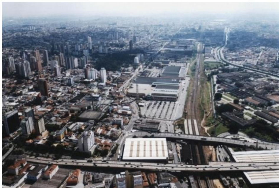
Figura 5 - Shopping ABC Plaza, localizado entre a Avenida Industrial (esquerda) e a via férrea (direita) Fonte: Texeira (2010)
