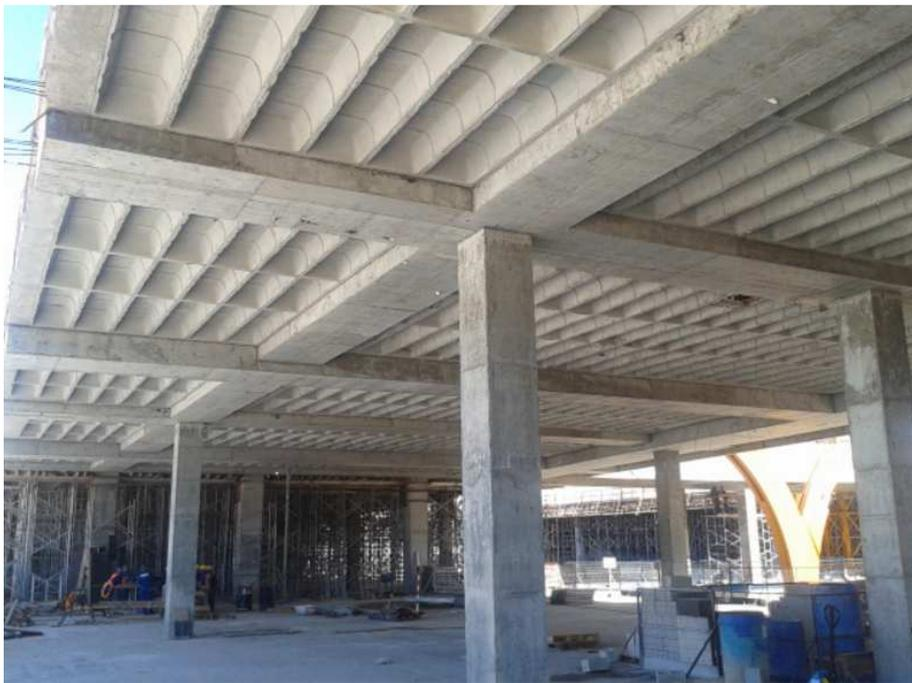
**Figura 1.7 - Laje nervurada unidirecional apoiada sobre faixas protendidas.**
