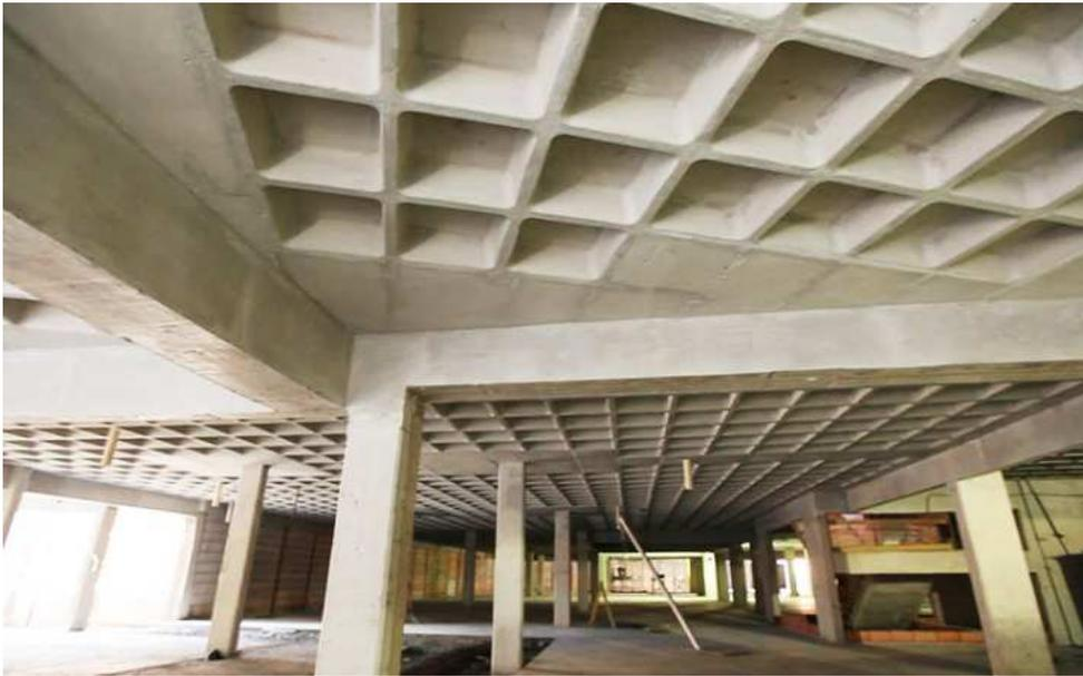
**Figura 1.6 - Laje nervurada bidirecional apoiada sobre vigas de concreto**
