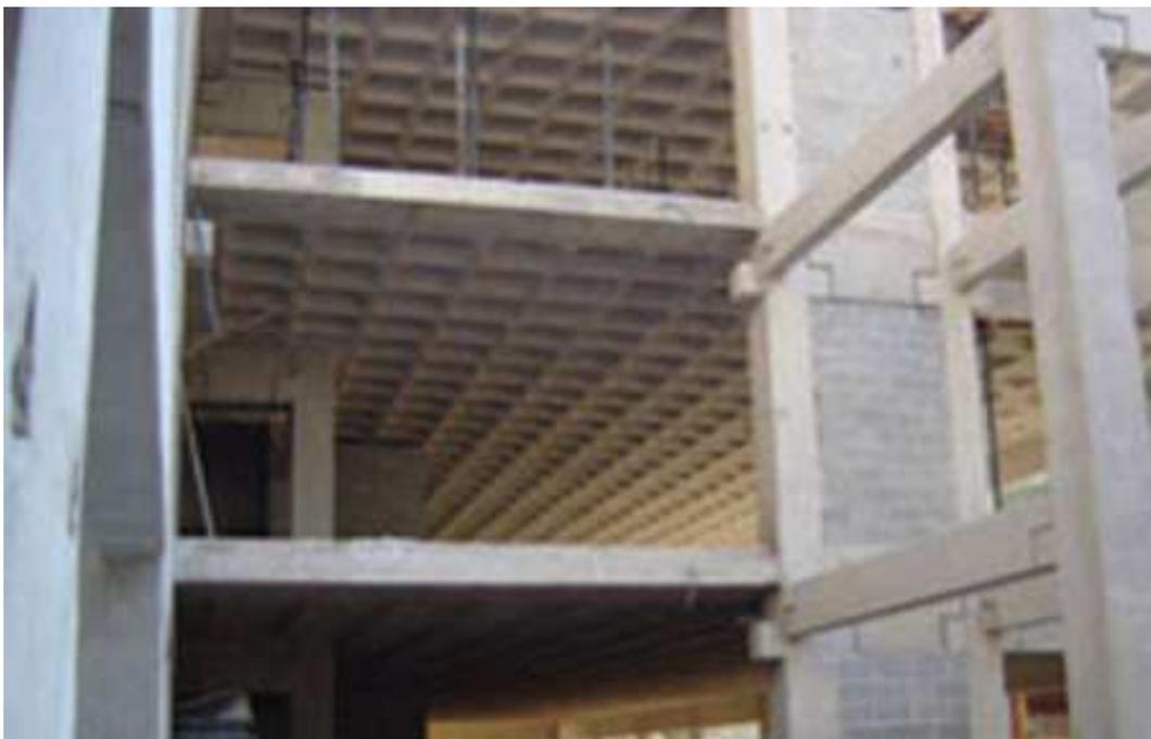
**Figura 1.8 - Laje nervurada apoiada sobre vigas e pilares pré-moldados.**
