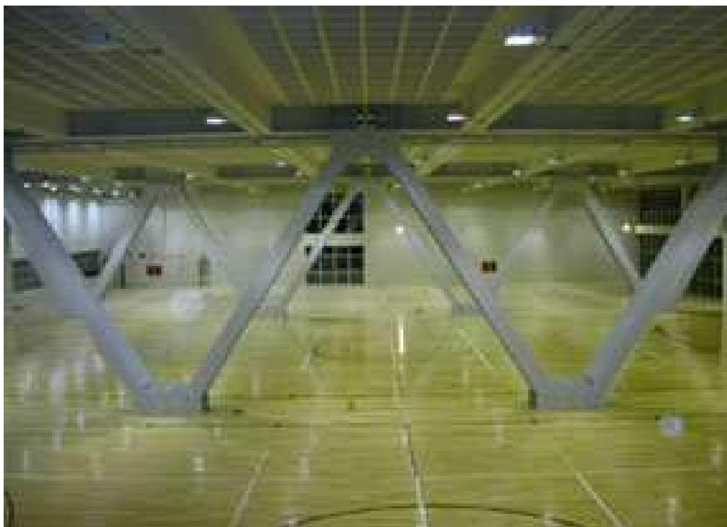
**Figura 1.9 - Laje nervurada apoiada sobre vigas e pilares metálicos.**
