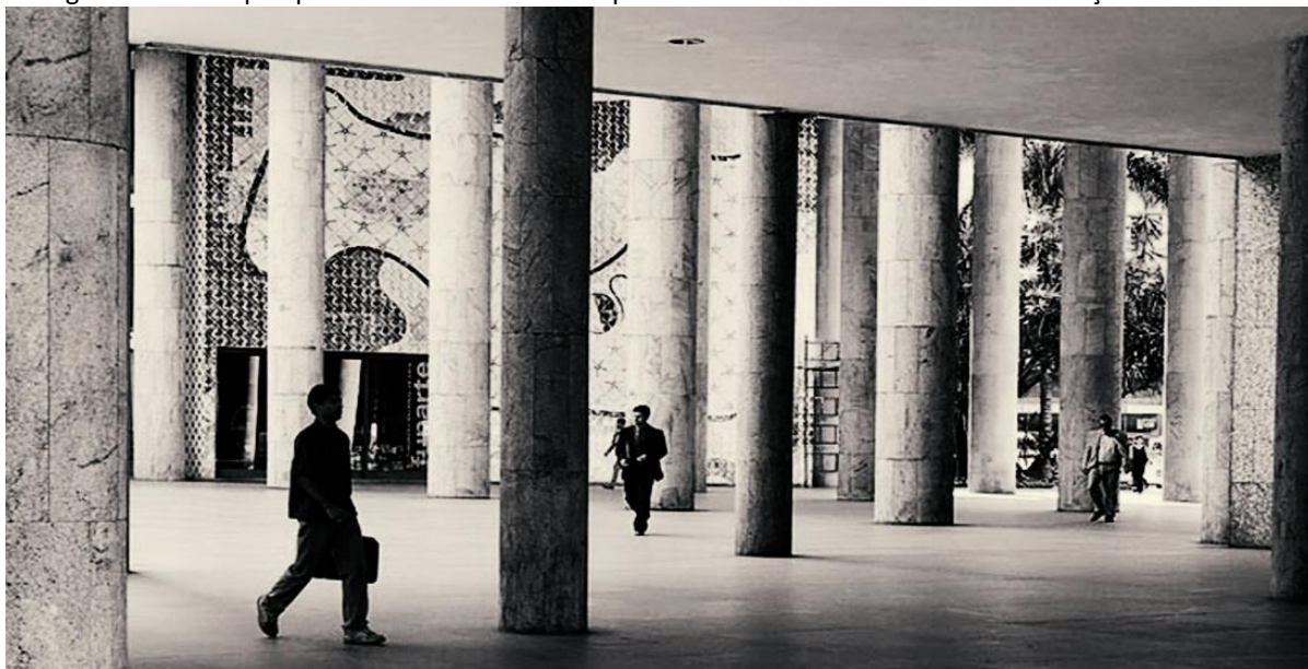
Imagem48 - Outra perspectiva da continuidade espacial do edifício do Ministério da Educação e Saúde-MES.
