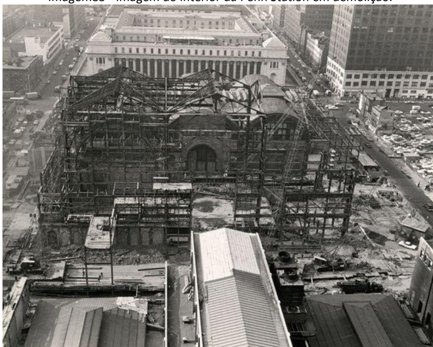
Imagem83 - Imagem do interior da Penn Station em demolição.
