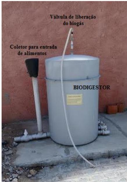
Figura 19 (4): Biodigestor – vista frontal
