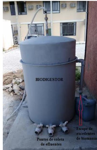
Figura 20 (4): Biodigestor – vista lateral
