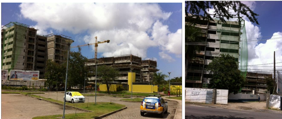
Figura 24 - Fotos da construção de um conjunto residencial no bairro de Monteiro. Fotos – Aliomar Nunes, março de 2015.
