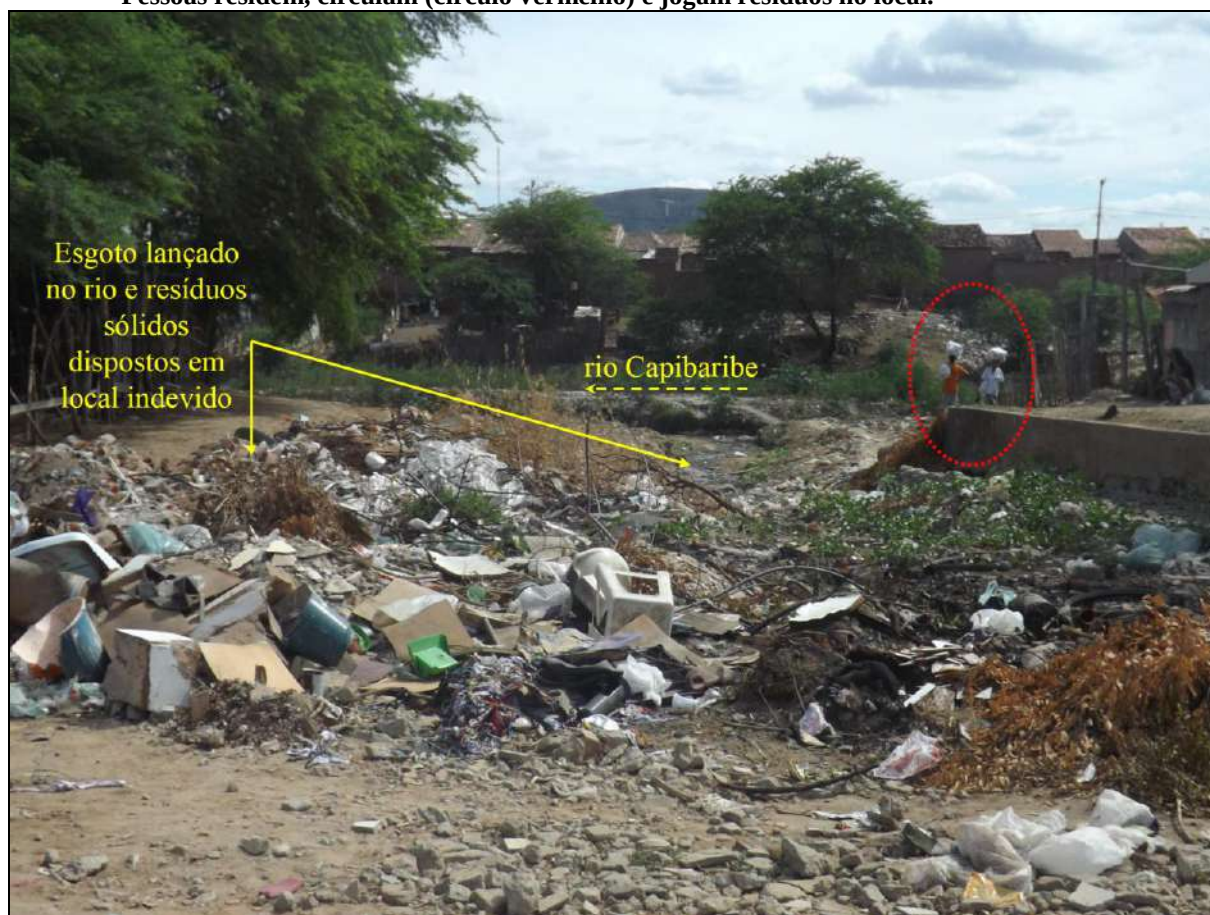
Figura 40. Disposição indevida de lixo e esgotos lançados no rio na cidade de Santa Cruz do Capibaribe. Pessoas residem, circulam (círculo vermelho) e jogam resíduos no local.
