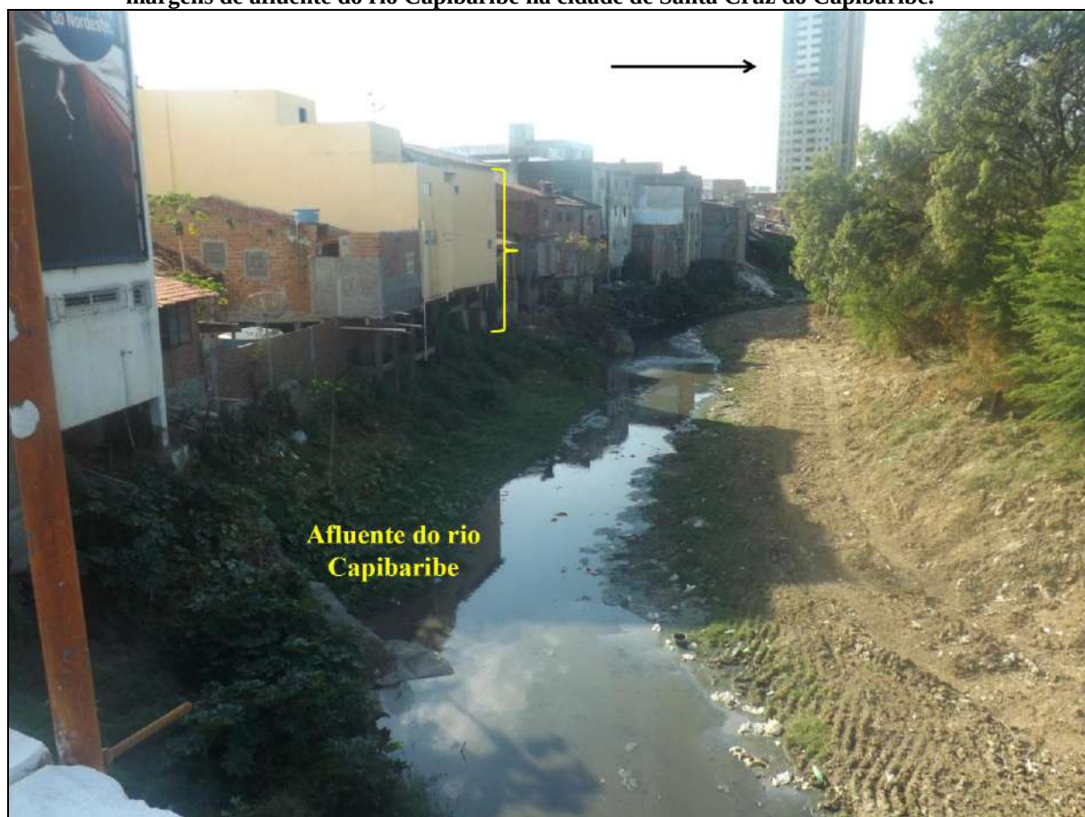
Figura 38. Unidades residenciais de até três pavimentos (e.g. chave) e prédio de vários andares (seta) às margens de afluente do rio Capibaribe na cidade de Santa Cruz do Capibaribe.
