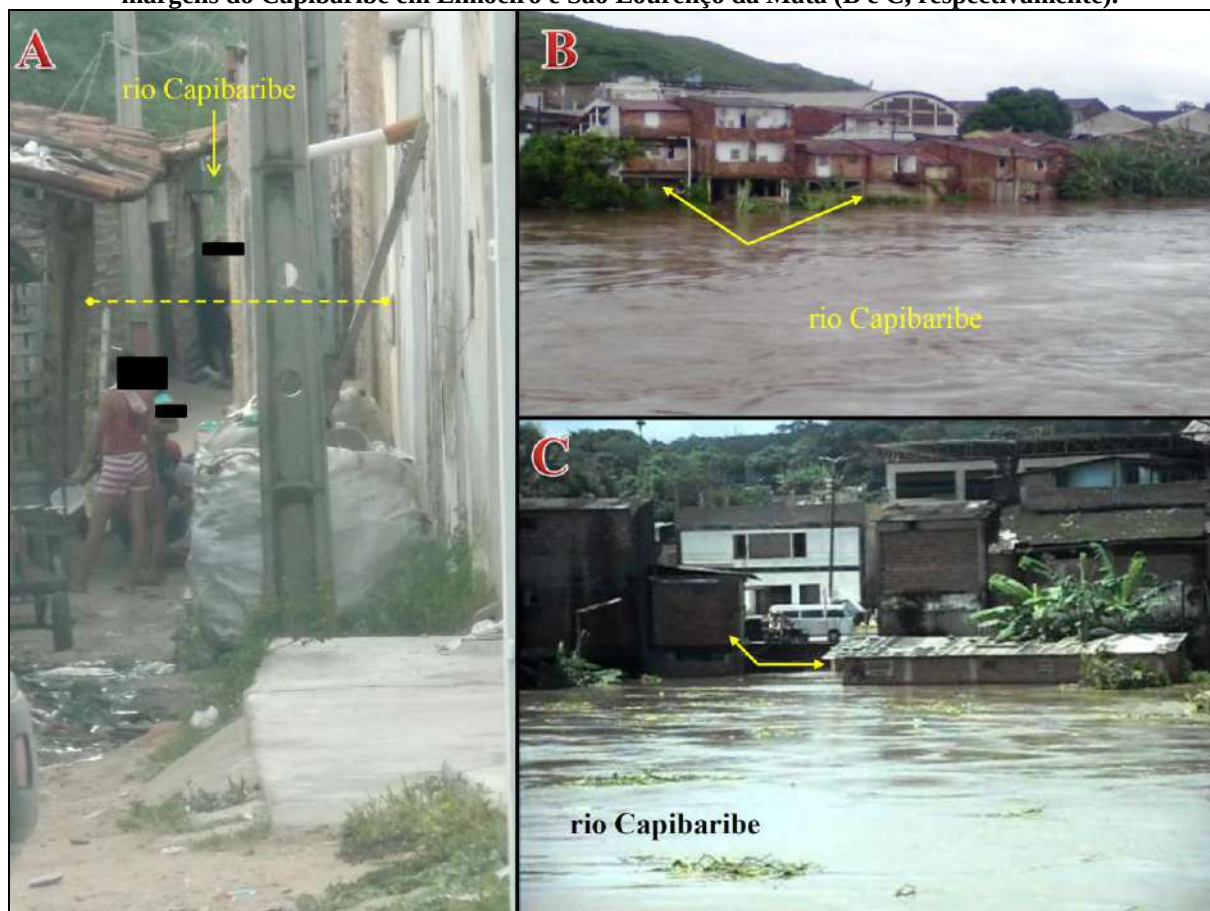
Figura 39. Moradores de localidade pobre em vias de circulação estreita às margens do rio Capibaribe em Sta. Cruz do Capibaribe (A); residências com condições estruturais inadequadas localizadas nas margens do Capibaribe em Limoeiro e São Lourenço da Mata (B e C, respectivamente).
