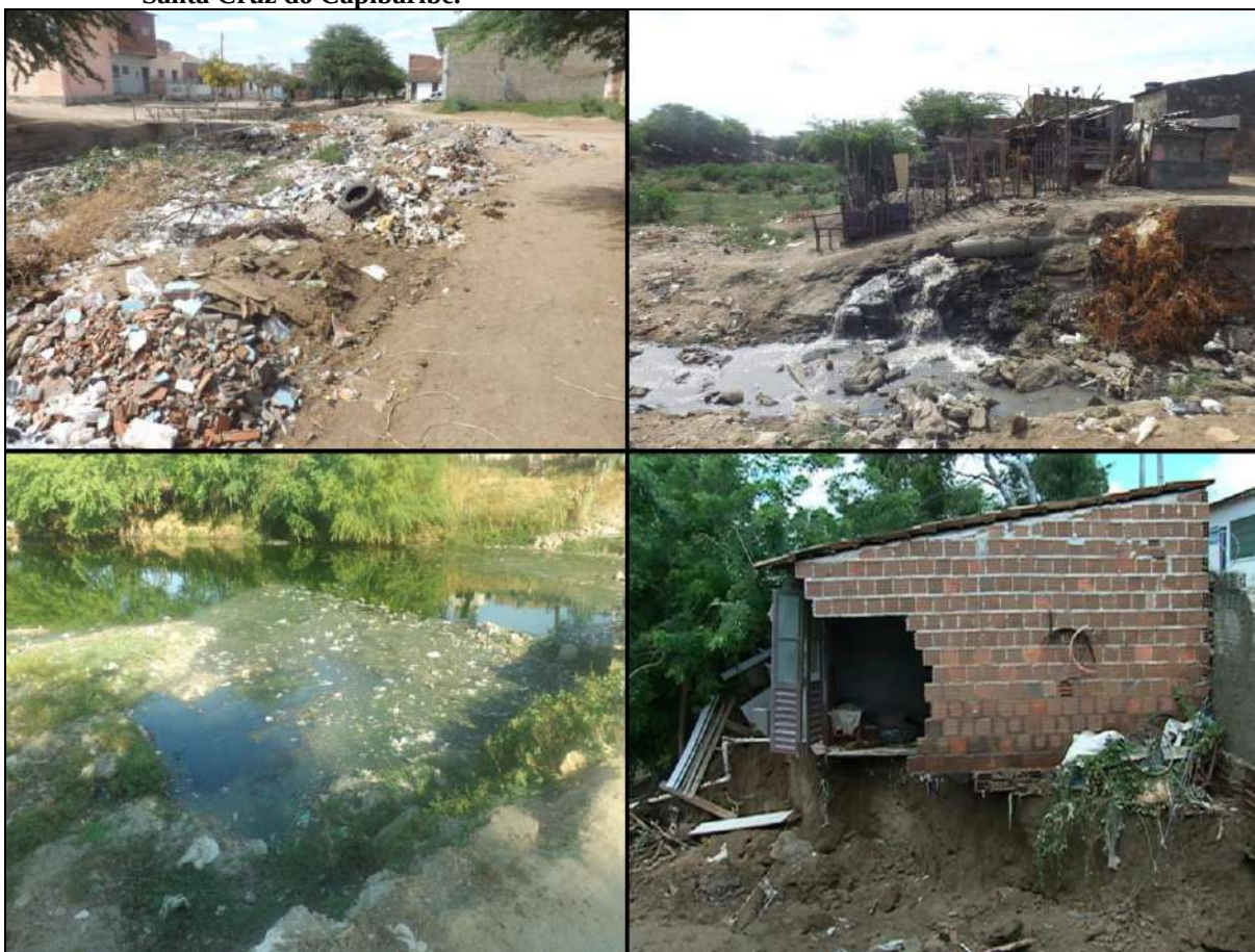
Figura 45. Estado de ocupação e problemas socioambientais nas margens do rio Capibaribe na cidade de Santa Cruz do Capibaribe.
