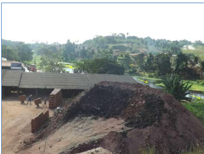
Unidade de produção de tijolos em Paudalho, localizada às margens do rio Capibaribe. Setas indicam o sentido montante – jusante do rio.
