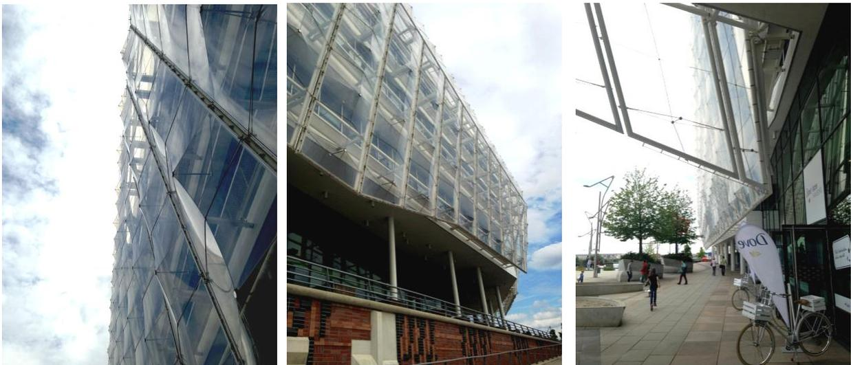
Fig. 86, 87, 88 – Edifício Unilever - fachada dupla com película em ETFE.
