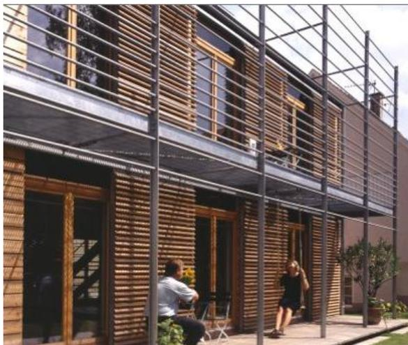
Fig. 149 – Pérgula metálica da fachada oeste.
