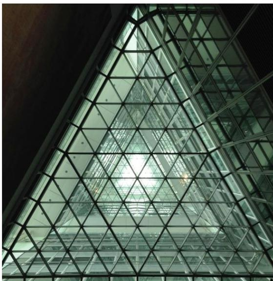
Fig. 22 – Átrio central da Torre – iluminação e ventilação natural. Foto: O autor, 2015.
