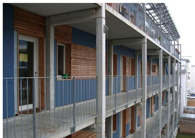
Fig. 126 – Estrutura metálica na fachada norte
