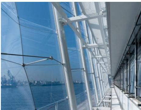
Fig. 90 – Janelas superiores protegidas pela superfície em ETFE. Fonte: behnisch.com, acesso em 21.06.16
