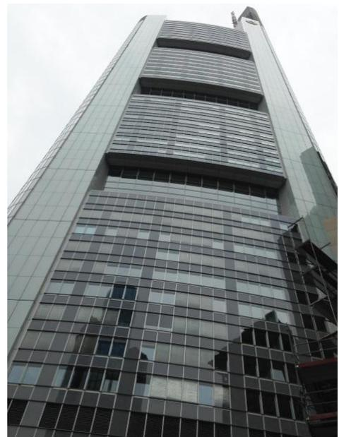
Fig. 27 – Revestimentos em grelha regular metálica das esquinas curvas do edifício.
