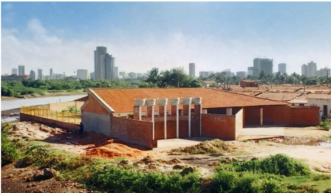
Fig. 170 – Escola Novo Mangue – Materiais externos isentos de revestimentos.
